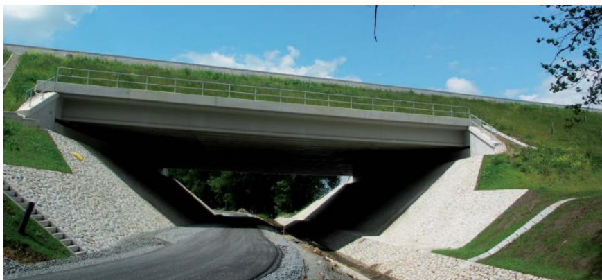
Obr. 8: Celkový pohled na přesypaný most a pohled na nosníky mostu [32]
