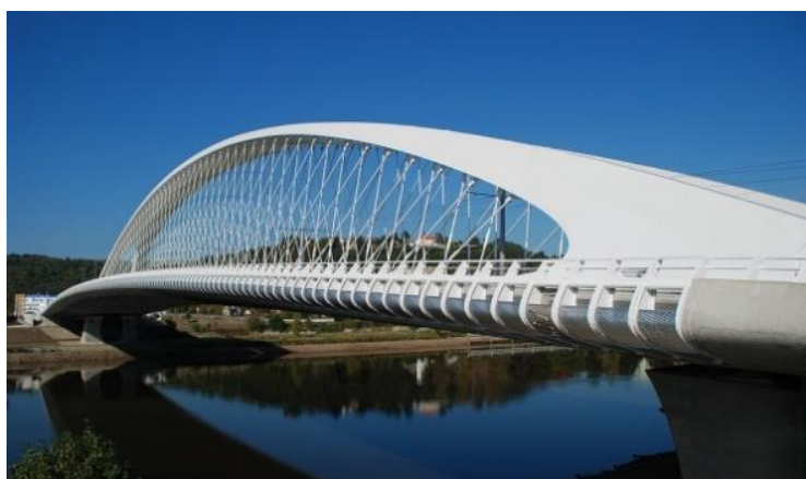
Obr. 10: Pohled na Trojský most [37]
