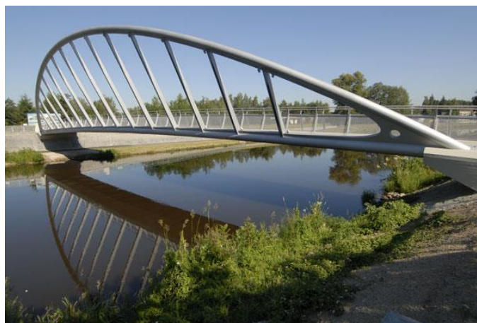
Obr. 9: Celkový pohled na lávku v Českých Budějovicích [32]
