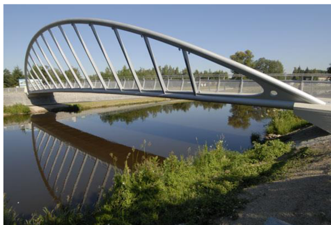
Obr. 9: Celkový pohled na lávku v Českých Budějovicích [32]
