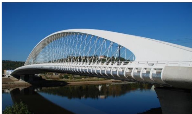
Obr. 10: Pohled na Trojský most [37]
