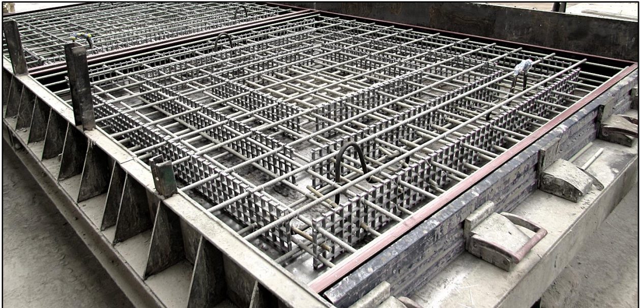
Obr. 79 Kompozitní výztuž zákrytové desky v bednění před betonáží
