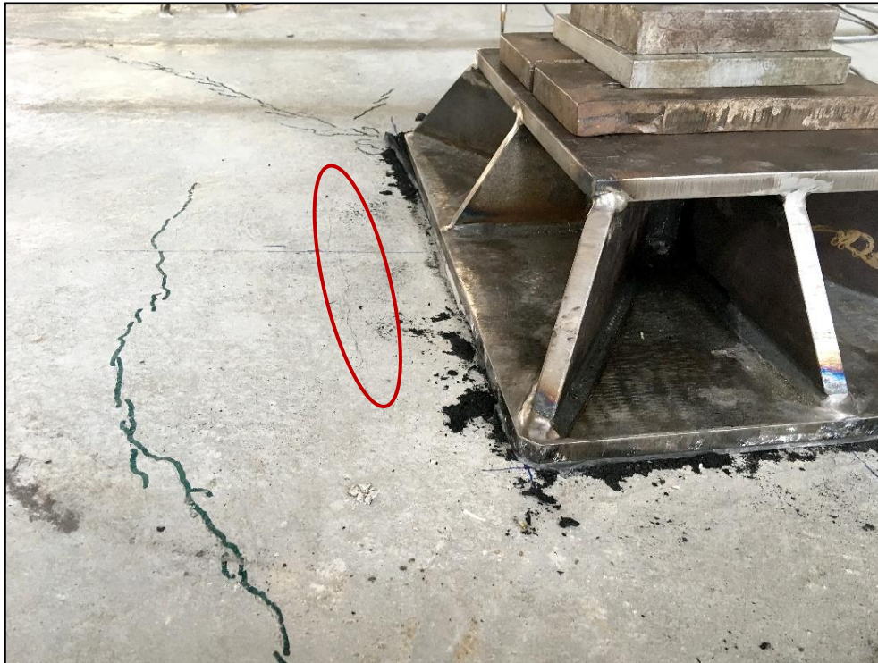
Obr. 119 Vytvoření trhliny rovnoběžně s roznášecí deskou
