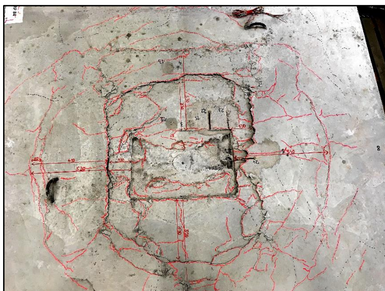
Obr. 95 Porušení horního povrchu vzorku z.GFRP.E.Ep.IV.N_4 se zvýrazněnými trhlinami po monotónním zatěžování
