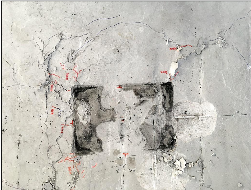
Obr. 109 Porušení horního povrchu desky z.GFRP.E.Ep.IV.N_1 po monotónním zatěžování
