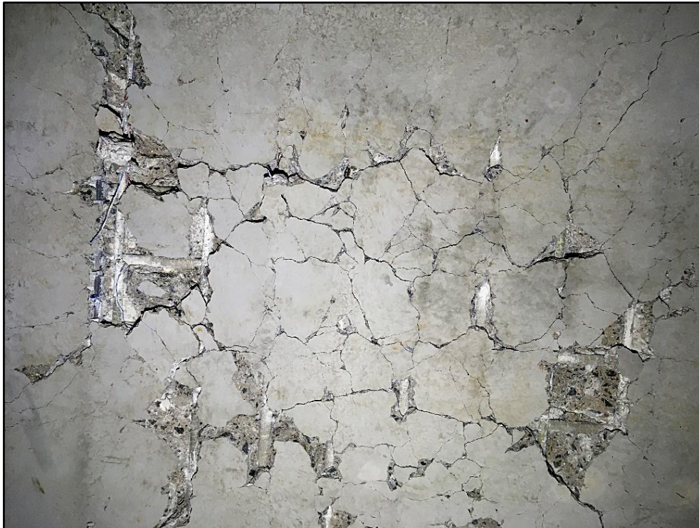
Obr. 113 Porušení spodního okraje uprostřed desky z.GFRP.E.Ep.IV.N_2 s místy odhalenou porušenou výztuží
