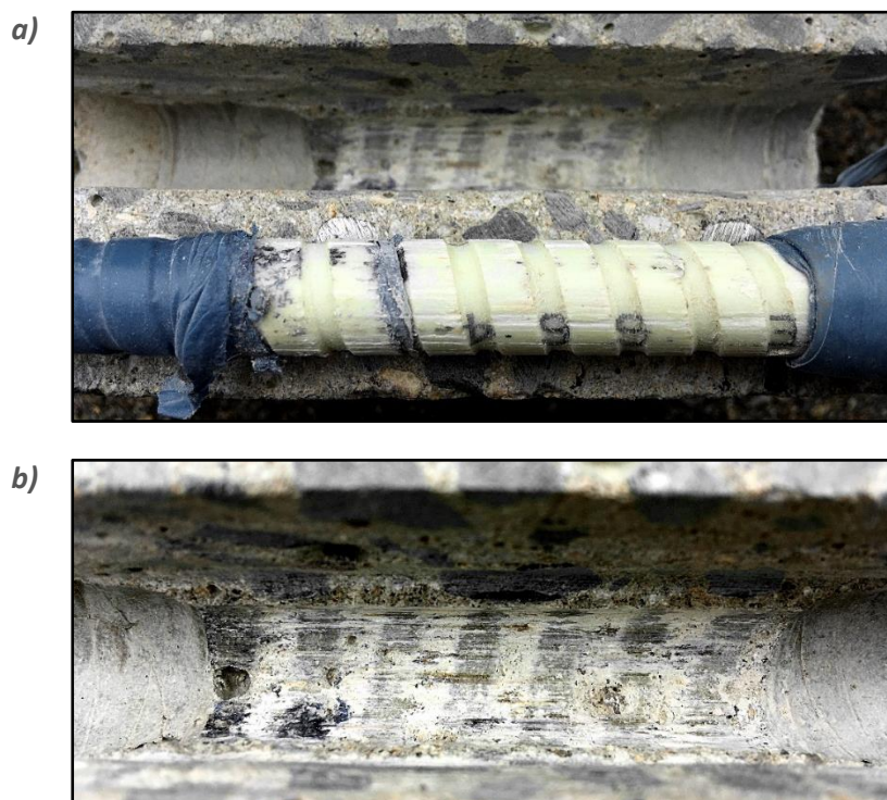
Obr. 47 Porušení soudržnosti vzorků GFRP.E.VE.R.12: a) prut s neporušenými žebírkami a odřeninami od kameniva; b) smykové porušení betonu v úrovni žebírek
