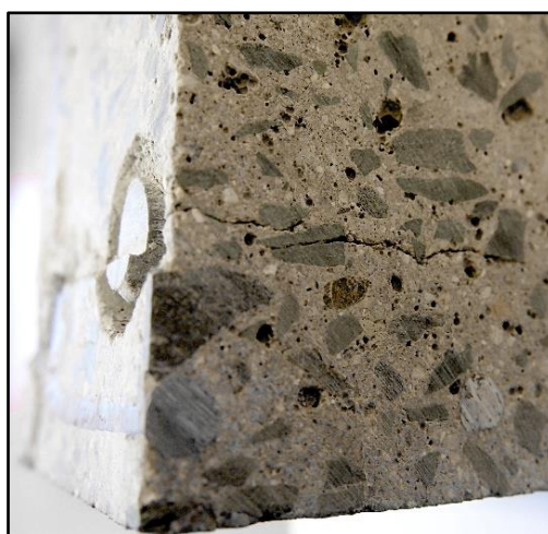
Obr. 25 Podélná trhlinka v betonu v oblasti soudržnosti
