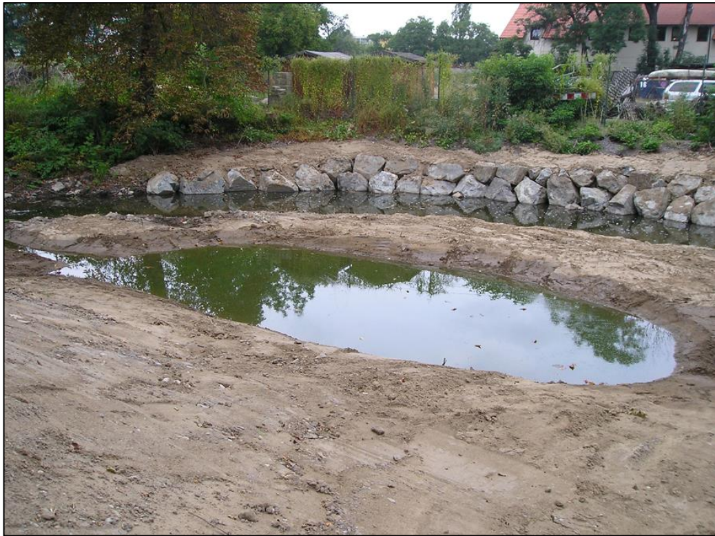
Obr. 70. Větší tůň u Botiče na Kozinově náměstí. Stav těsně po dokončení (r. 2009; URL 28)
