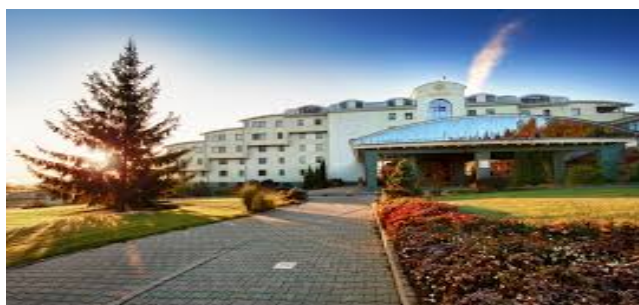
Obr. 4: Hotel Kaskády - vonkajší pohľad
