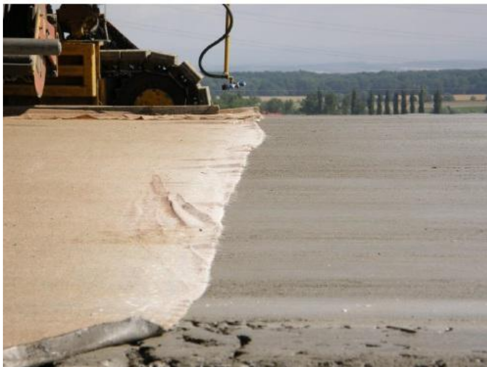
Obr. 25: Zajišťování textury vlečenou jutou [26]
