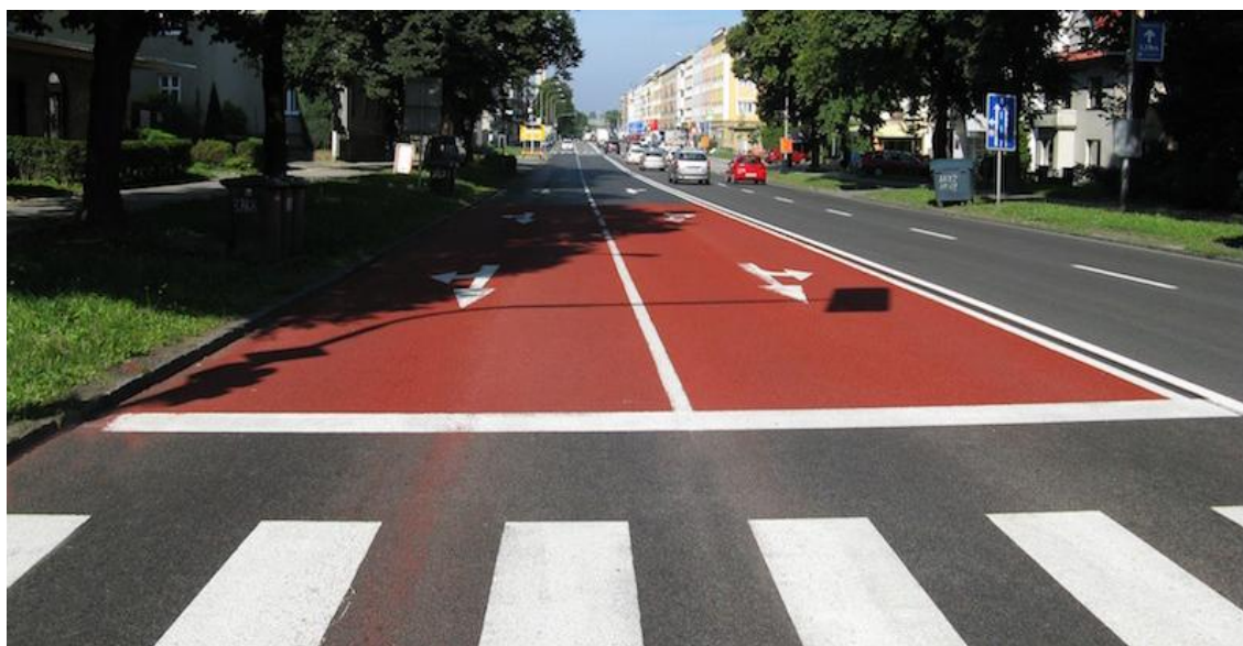
Obr. 35: Úprava systémem Rocbinda [23]
