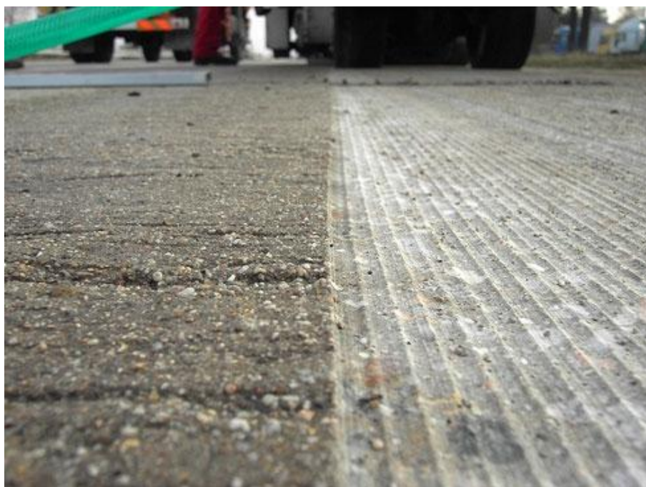
Obr. 30: Textura vozovky před a po broušení [22]
