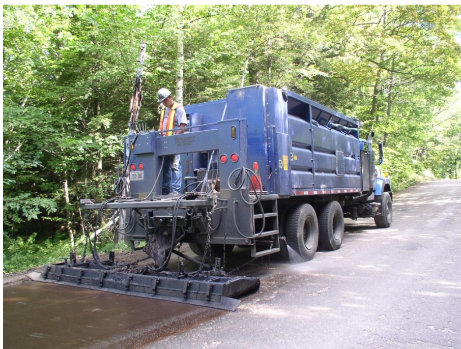
Obr. 21: Pokládání zákrytu Slurry seal [12]
