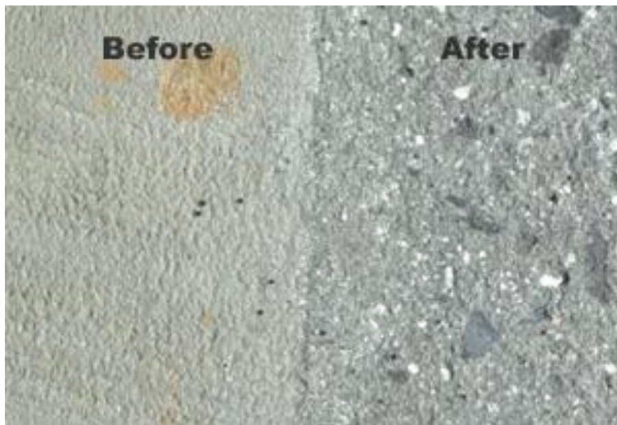
Obr. 28: CB kryt před a po otryskání ocelovými kuličkami [27]
