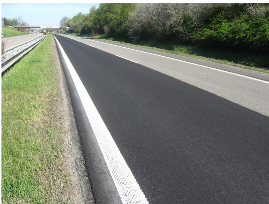
Obr. 22: Vozovka po a před pokládkou mikrokoberce [13]
