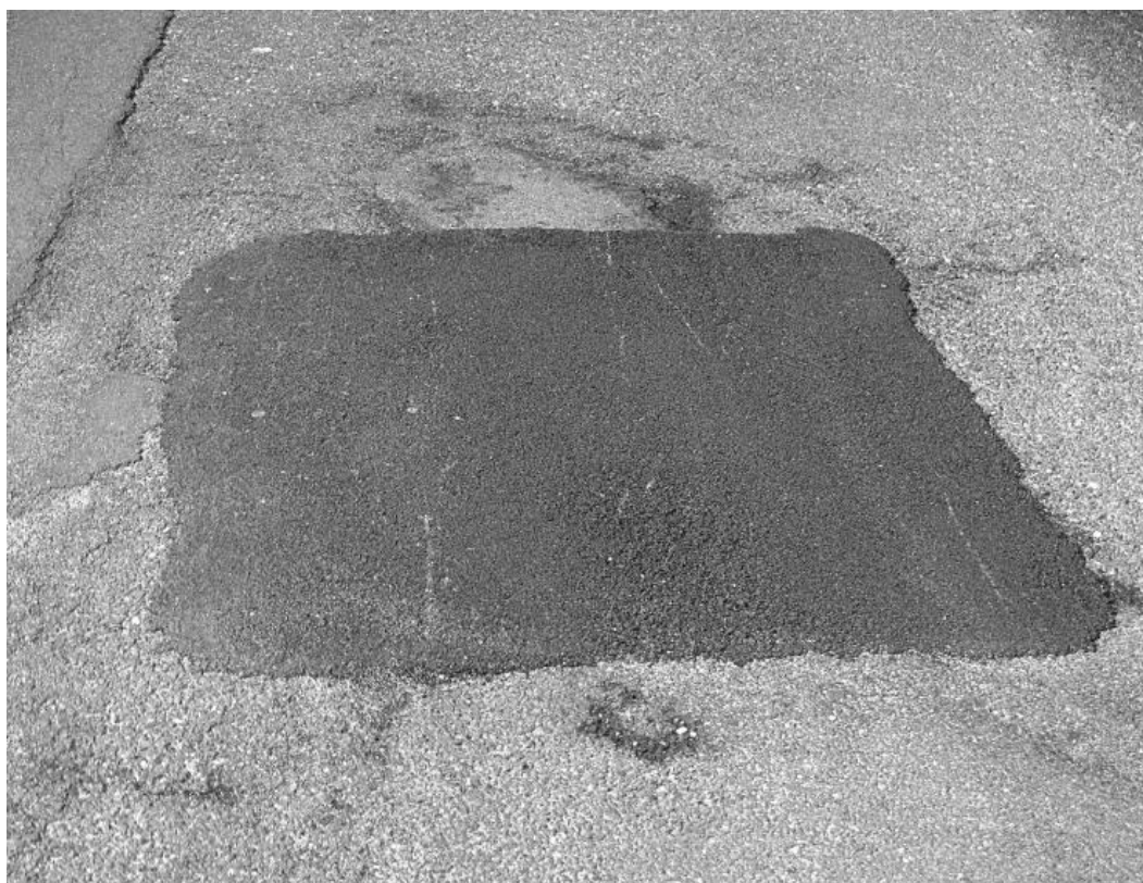
Obr. 19: Lokální oprava tryskovou metodou
