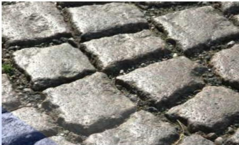
Obr. 16: Ztráta mikrotextury u vozovky z dlažebních prvků [5]
