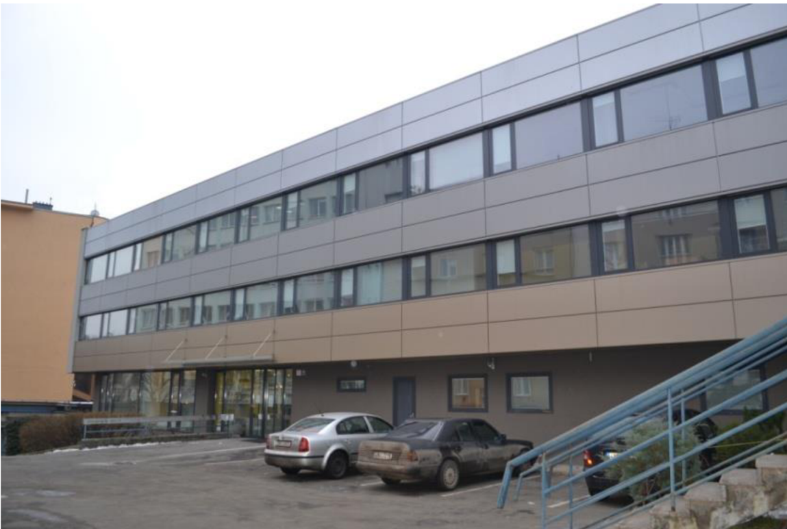
Obr. 17 Kancelářská budova firmy ENBRA a.s.
