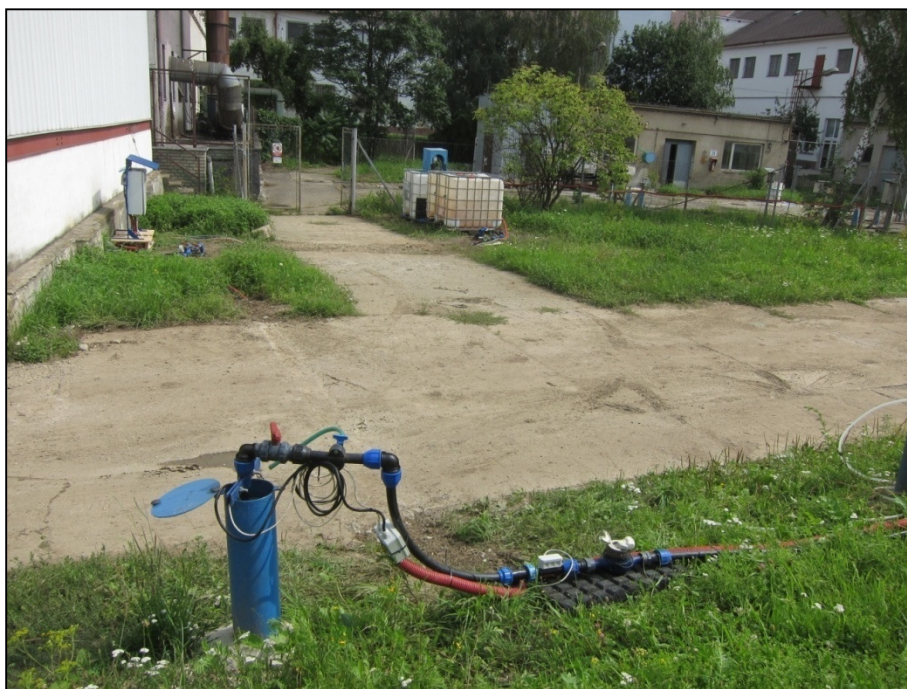
Obr. 12: Aplikace syrovátky při pilotní zkoušce (v popředí čerpací vrt HS-1)
