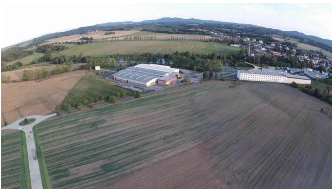
Obr. č. 22 Křižovatky na silnici II/157 - po realizaci
