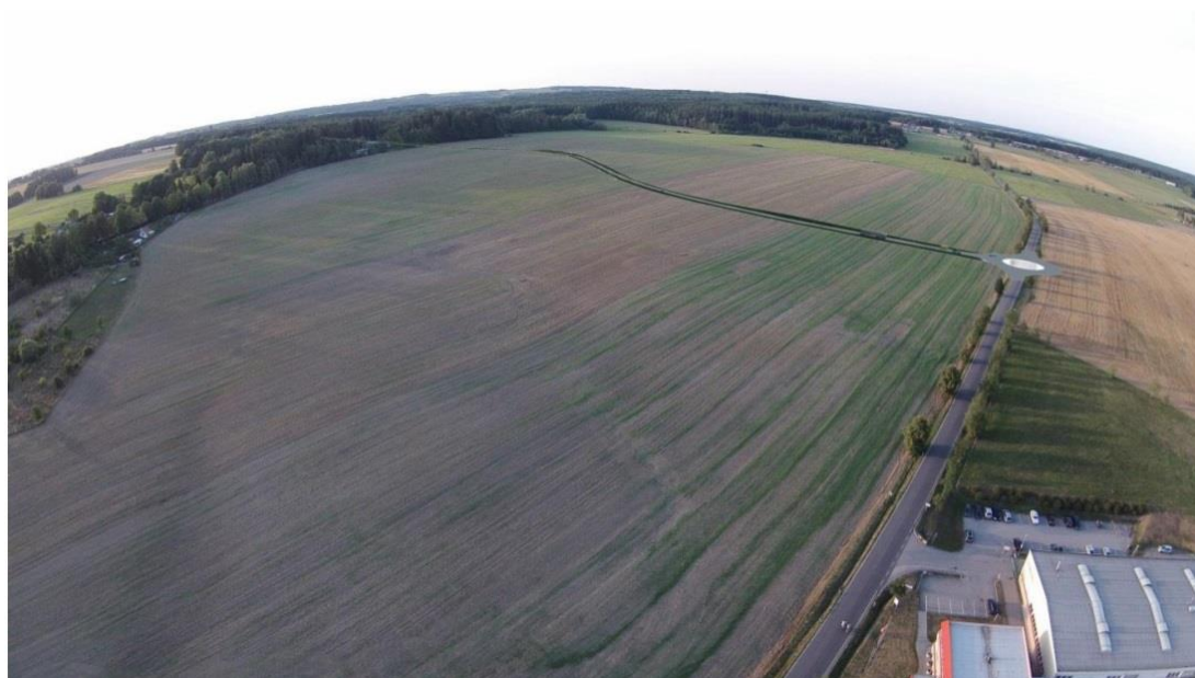
Obr. č. 20 Napojení na silnici II/157 - po realizaci
