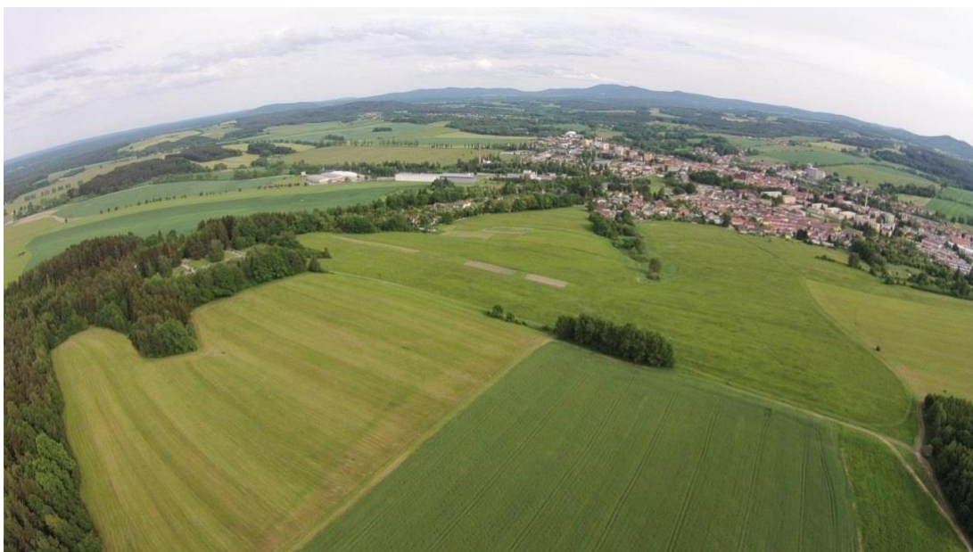
Obr. č. 17 Vedení trasy u hřbitova - před realizací
