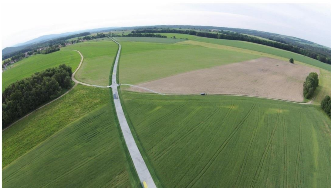
Obr. č. 16 Napojení účelové komunikace - po realizaci
