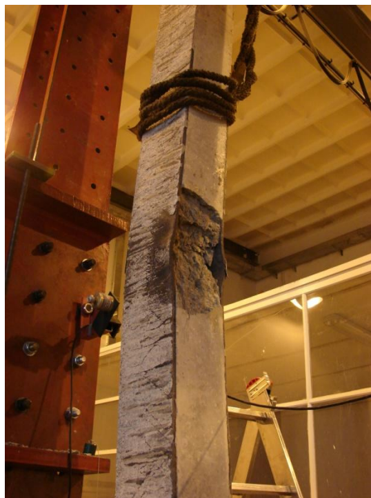
Obr. E.28 Tlakové porušení betonu na konvexní straně uprostřed rozpětí prutu
