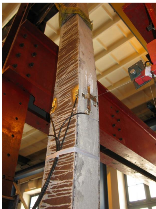
Obr. E.22 Tahové porušení betonu na konkávní straně uprostřed rozpětí prutu
