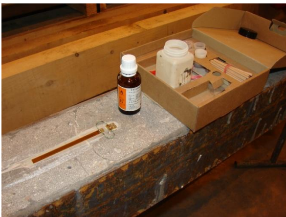
Obr. E.9 Lepení tenzometrů LY 41 100/120 na betonovou část průřezu
