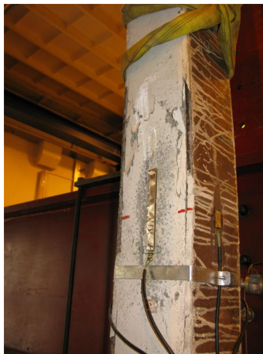
Obr. E.20 Tlakové porušení betonu na konvexní straně uprostřed rozpětí prutu
