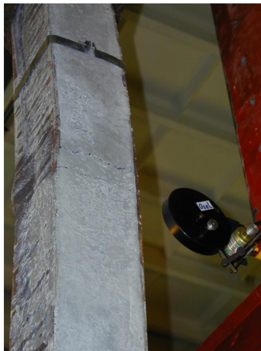
Obr. E.16 Tahové porušení betonu na konkávní straně uprostřed rozpětí prutu
