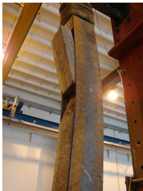
Obr. E.50 Oddělování betonových bloků po kolapsu sloupu
