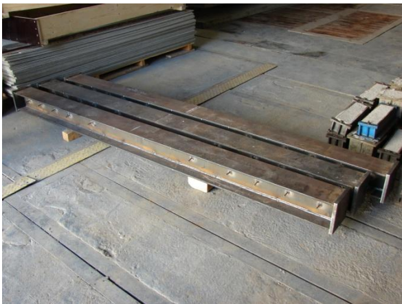
Obr. E.7 Navaření trnů na stojinu sloupu pro zajištění betonu proti vypadnutí
