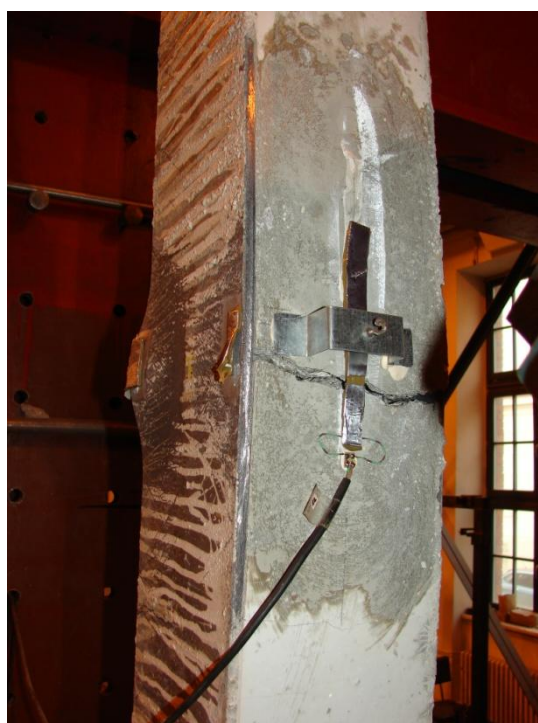
Obr. E.30 Tahové porušení betonu na konkávní straně uprostřed rozpětí prutu
