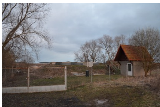
obr. 24, ČOV Kšice (foto autor 2021)
