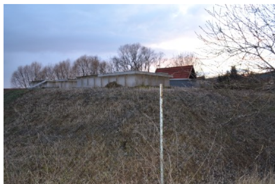
obr. 25, ČOV Kšice (foto autor 2021)
