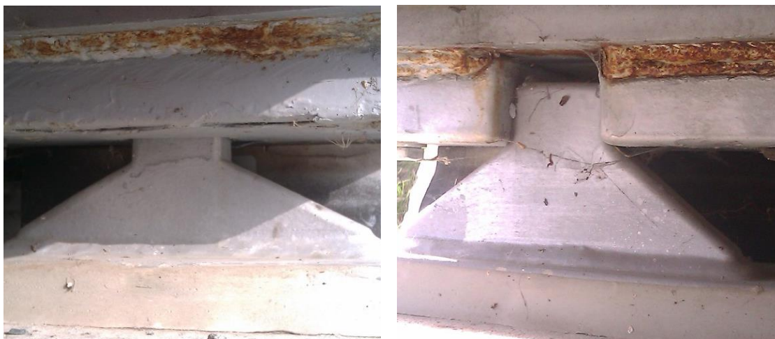
Obr. 25 Elastomerová ložiska: a) pevné; b) podélně posuvné
