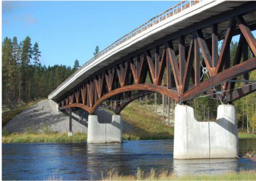
Obr. 7 Příhradový most přes řeku Reno, Norsko ( https://www.regjeringen.no )
