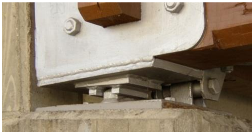
Obr. 27 Vahadlové ložisko ( http://www.konstrukce-tesko.cz/ )
