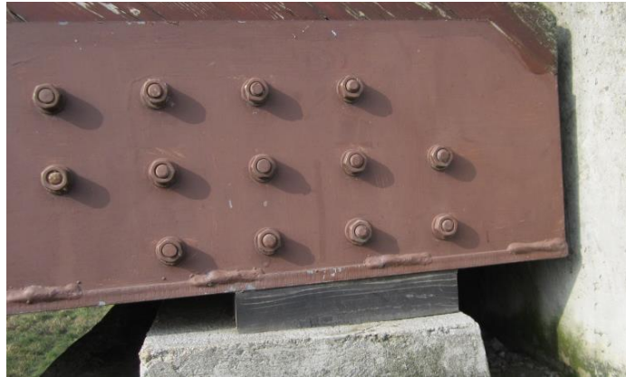
Obr. 24 Elastomerové ložisko obloukové lávky
