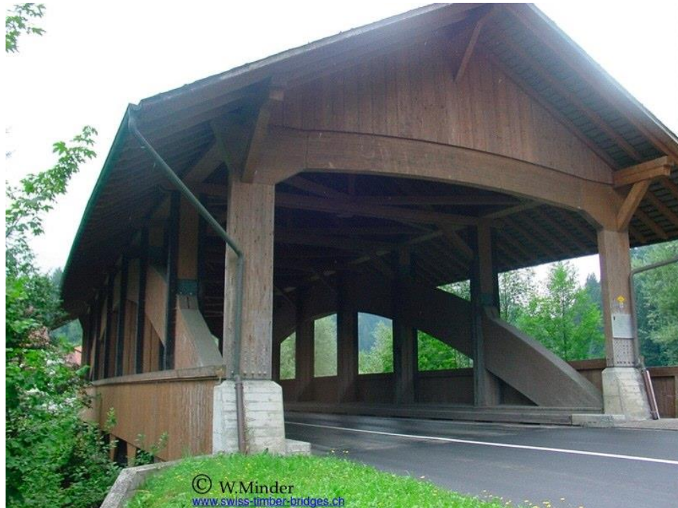
Obr. 10 Zastřešený dřevěný most ve Švýcarsku ( http://www.swiss-timber-bridges.ch/ )
