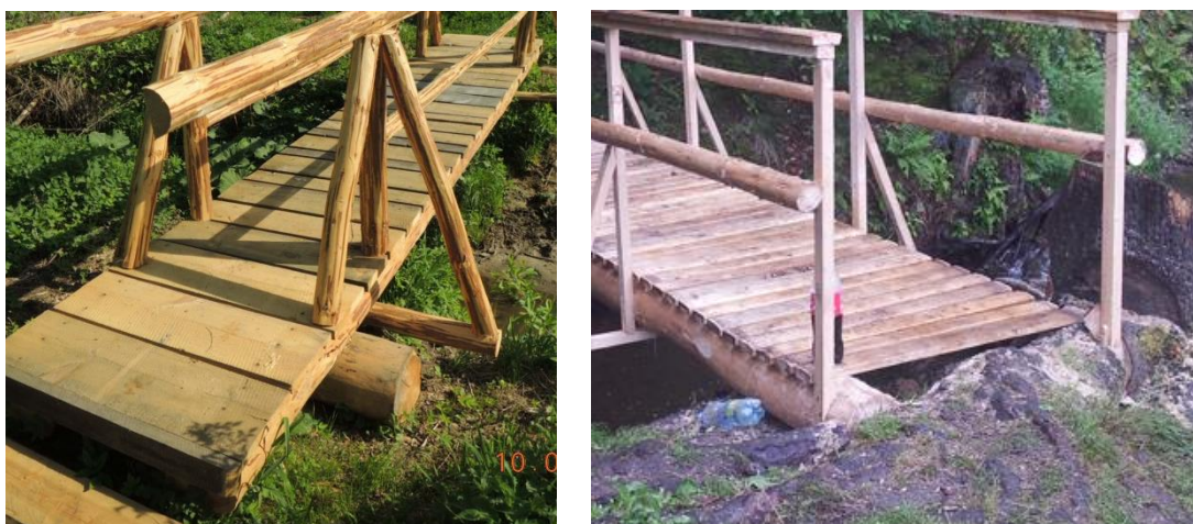
Obr. 21 Bezložiskové uložení lávky: a) uložení na opěru z kulatiny; b) uložení přímo do terénu, bez opěry ( http://www.geocacher.cz/ ; http://drevoop.cz/ )
