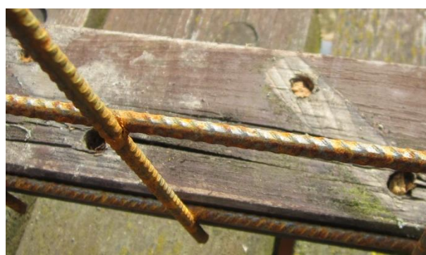
Obr. 34 Chybně zvolené spoje a spojovací prostředky: a) ukotvení mostovky; b) připevnění výplně zábradlí pomocí dřevěných kolíků
