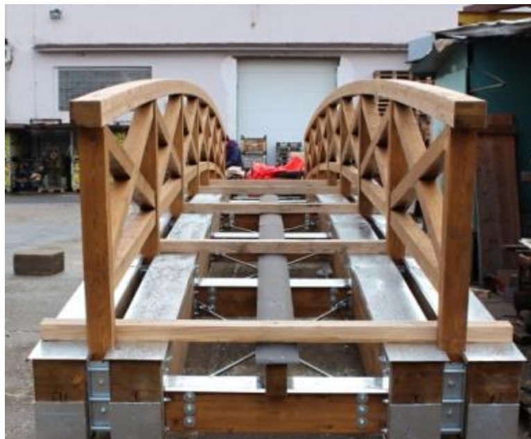
Obr. 31 Oplechování čtyř nosných nosníků a příčnicků lávky ( http://www.lekon-tsk.cz/ )
