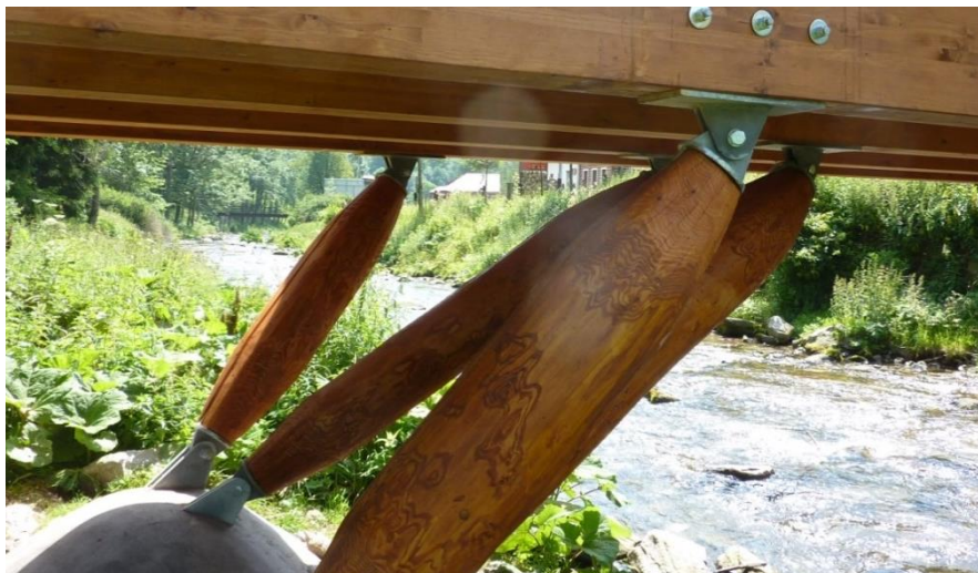
Obr. 30 Lávka v Úpě tvořená ze čtyř spojitých nosníků, podpěry jsou uloženy kloubovými ložisky ( http://www.svp-mosty.cz/ )
