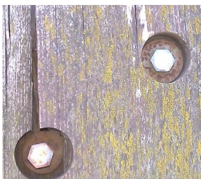
Obr. 34 Chybně zvolené spoje a spojovací prostředky: a) ukotvení mostovky; b) připevnění výplně zábradlí pomocí dřevěných kolíků
