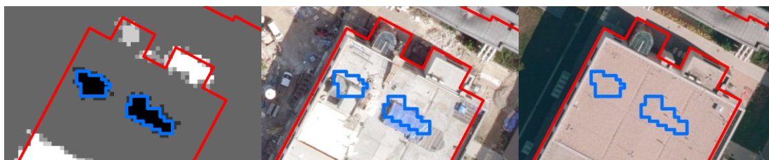
Obr. 49 Odstraněné dočasné konstrukce na střeše budovy – polygony č. 1, 2 (zdroj: LLS 2020-2023, Ortofoto ČR 2022, 2024)
