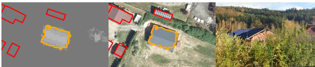
Obr. 84 Nová budova – polygon č. 3 (zdroj: LLS 2022-2025, Ortofoto ČR 2023, Google Maps StreetView 2022)
