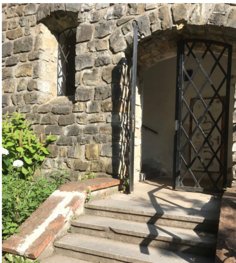
Obrázek 3.7: Úloha 2: Chůze po schodišti
