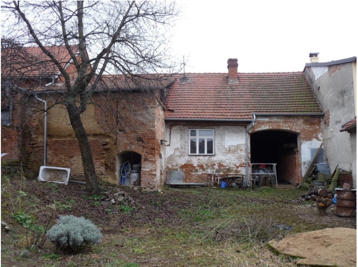
Obr. č. 17 - pohled ze dvora, v popředí na levé straně dvorní přístavek (Vlastní zpracování, 2023)
