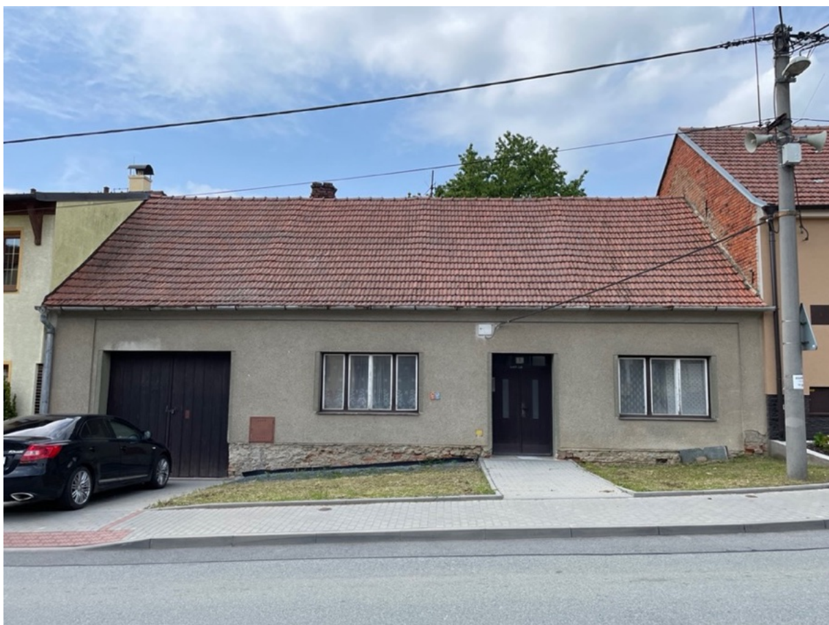
Obr. č. 18 - pohled z ulice (Vlastní zpracování, 2023)
