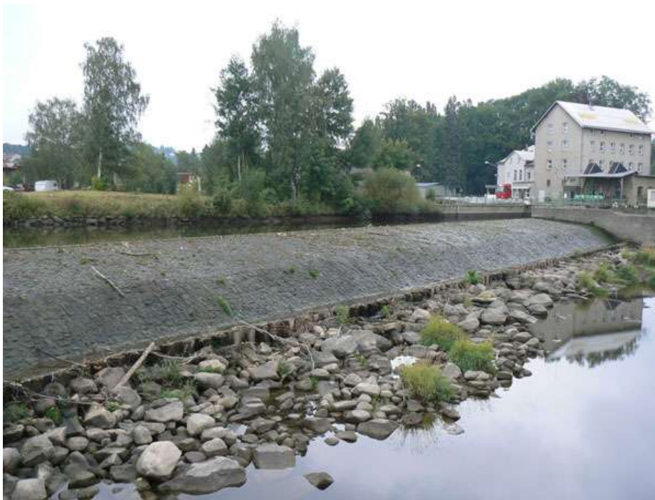
Obr. 27 Původní pevný jez na řece Jizeře (autor Ing. Olgerd Pukl, 2010)
