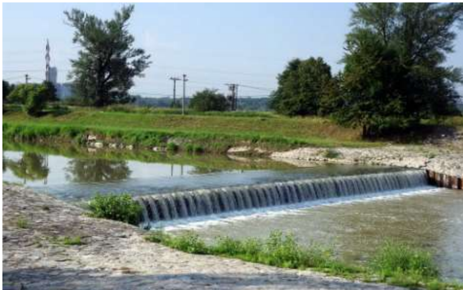
Obr. 5 Příklad spádového stupně na Olši (autor Povodí Odry, 2012)
