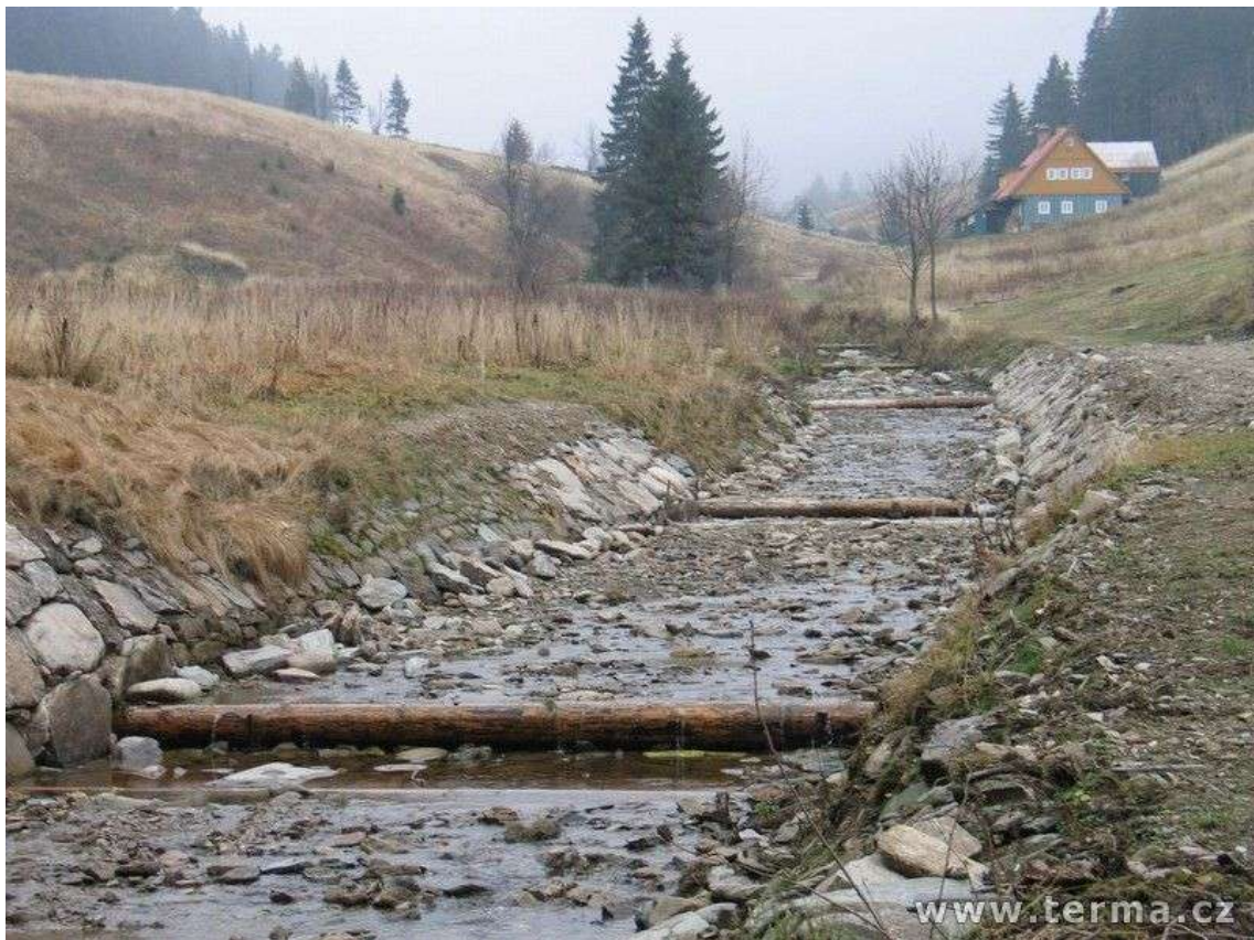
Obr. 2 Dřevěné stabilizační prahy (autor Terma, 2005)
