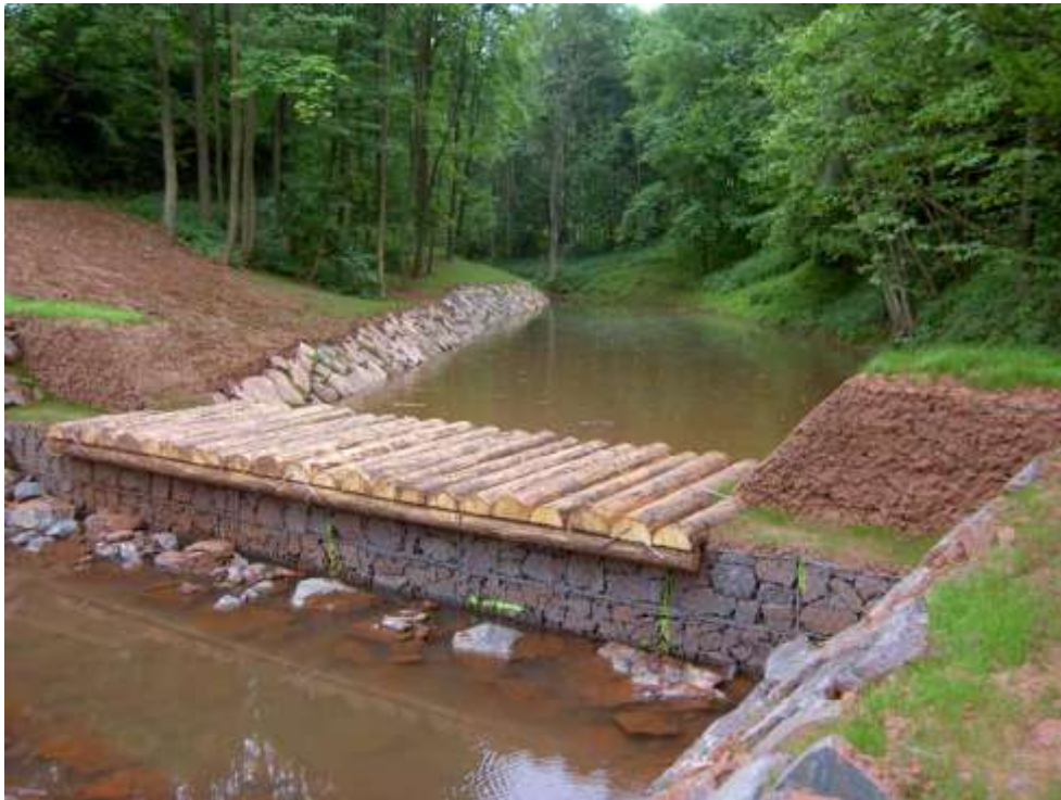
Obr. 9 Retenční přehrážka na Žďárském potoku (autor J. Mareš, 2008)
