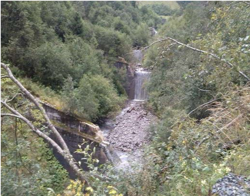
Obr. 8 Betonová přehrážka na řece Geißbach - Rakousko (autor Rašková, E., 2014)
