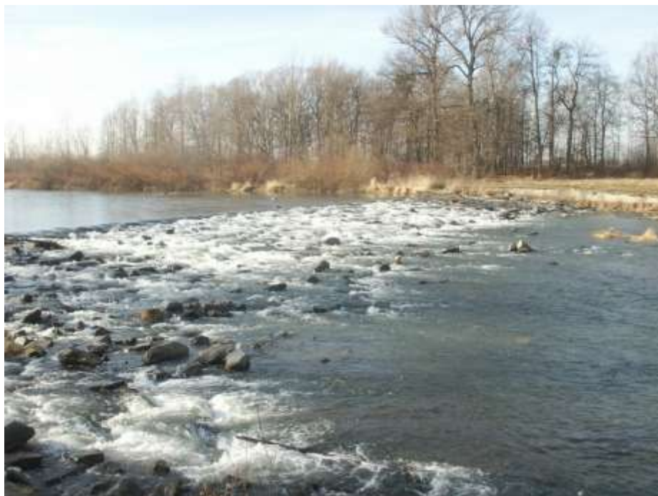
Obr. 25 Ostravice - balvanitý skluz (autor AGPOL, 2012)
