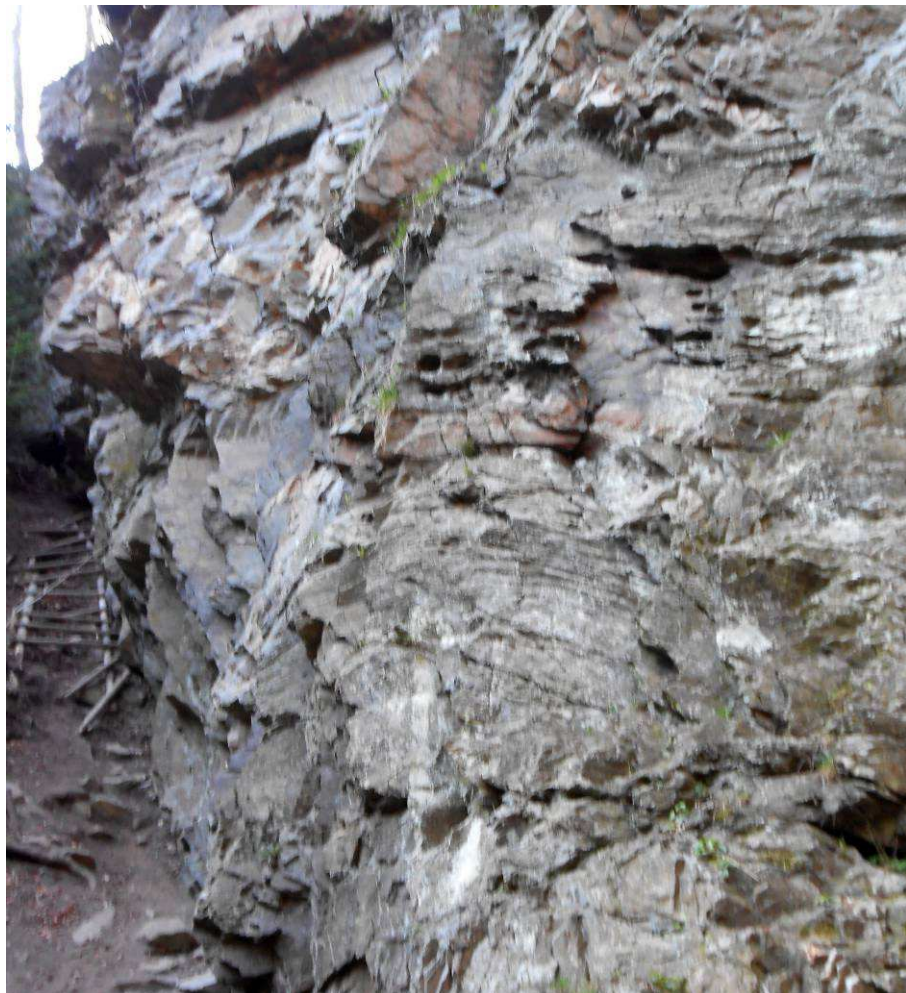
Obr. 12: Skalní dutiny a voštiny na stěně Sokolohradu (Lucie Radová 16. 3. 2014).
