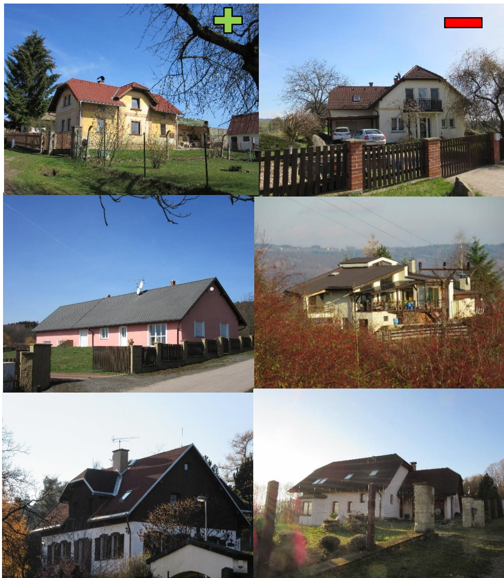
Obr.č. 13. Stávající zástavba v obci Brada- Rybníček s vyhovující a nevyhovující zástavbou chráněné krajinné oblasti Český ráj, zdroj: Martina Nekvasilová, 2016
