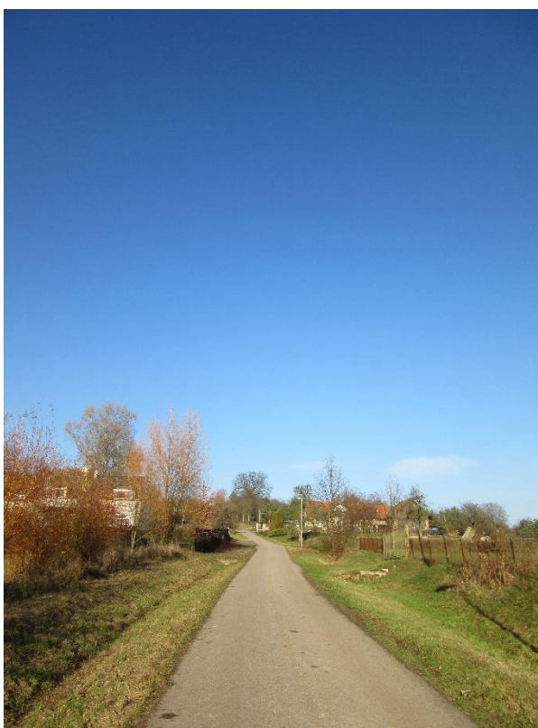
Obr.č. 9. Ukázka silniční komunikace v obci Brada – Rybníček, zdroj: Martina Nekvasilová, 2016
