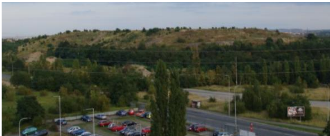
Obr.č. 18: Bývalá skládka TKO – pohled od Sídliště Modřany (foto vlastní)
