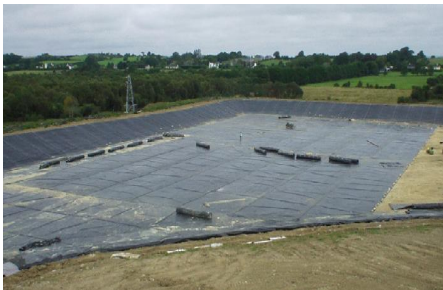
Obr.č. 11: Příprava izolace dna skládky z HDPE fólie (O'TOOLE et al., 2003)
