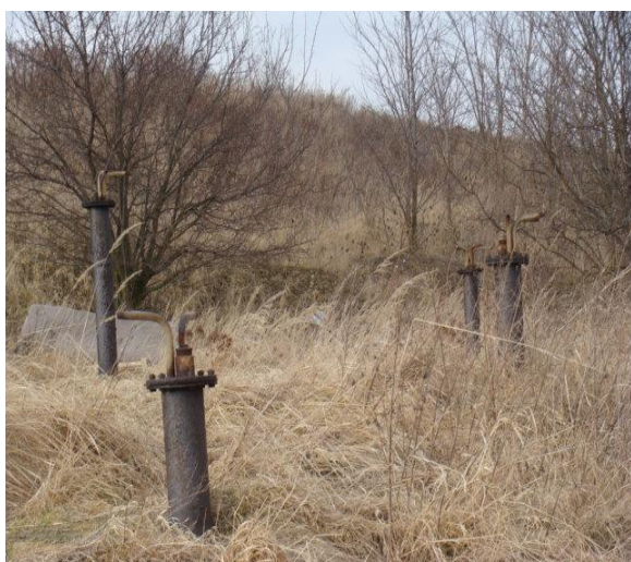
Obr.č. 25, 26: Plynosběrná potrubí z let 1984 (vlevo) a 1993 (fota vlastní)
