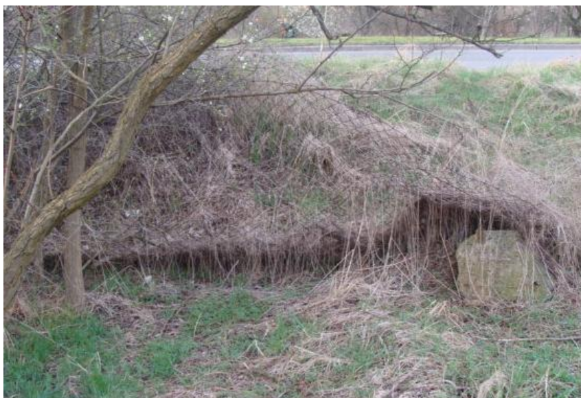
Obr.č. 27: Chátrající oplocení skládky (foto vlastní)
