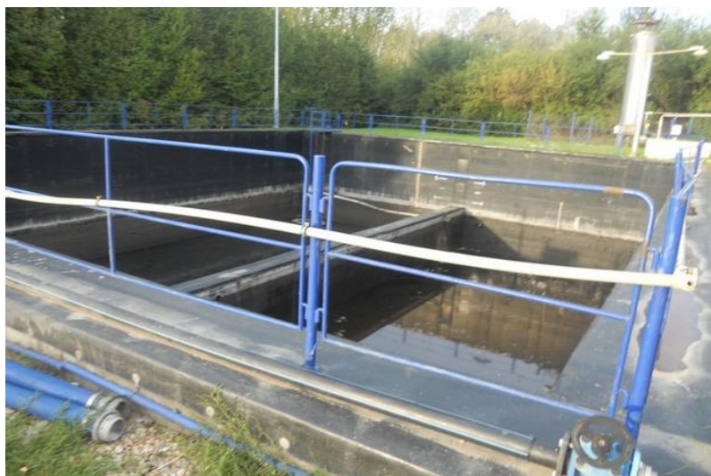
Obr.č. 14: Jímka průsakových vod u skládky Ďáblice (ŠINDLER, 2013)
