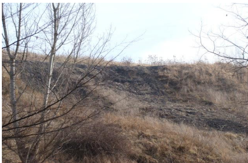
Obr.č. 23: Sesuv svahu v západní části skládky (foto vlastní)
