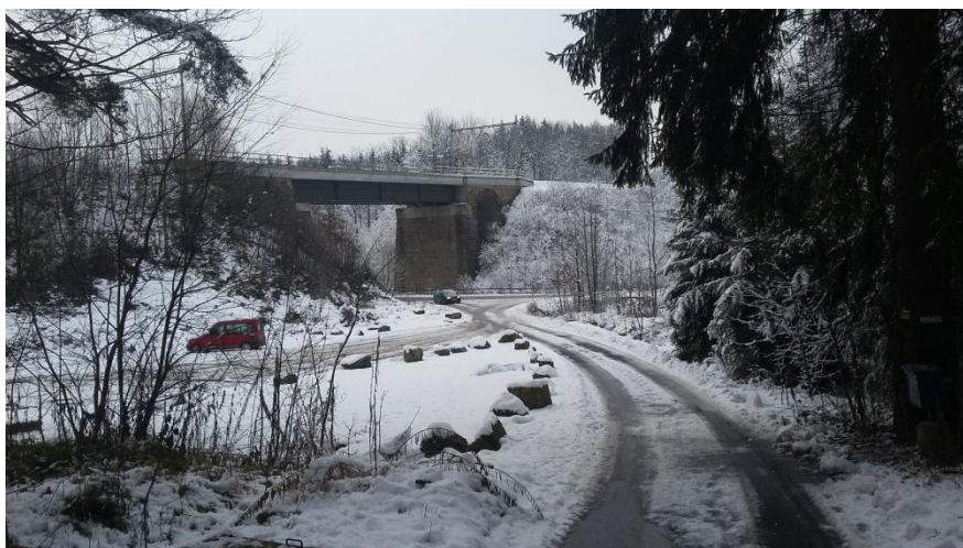
Obrázek č. 3: Pohled ze severu na viadukt železnice č. 320
