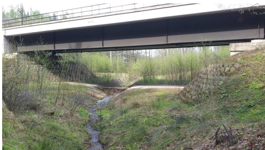
Obrázek č. 2: Podchod na 6. úseku transektu železnice č. 320
