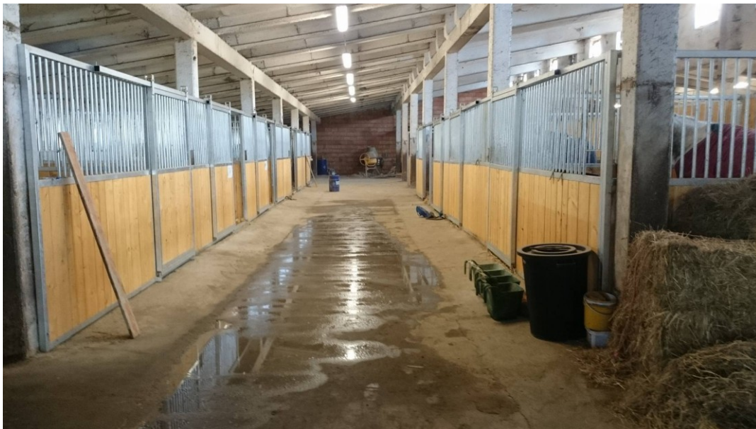
Obrázek 18. Nově budované vnitřní stáje
