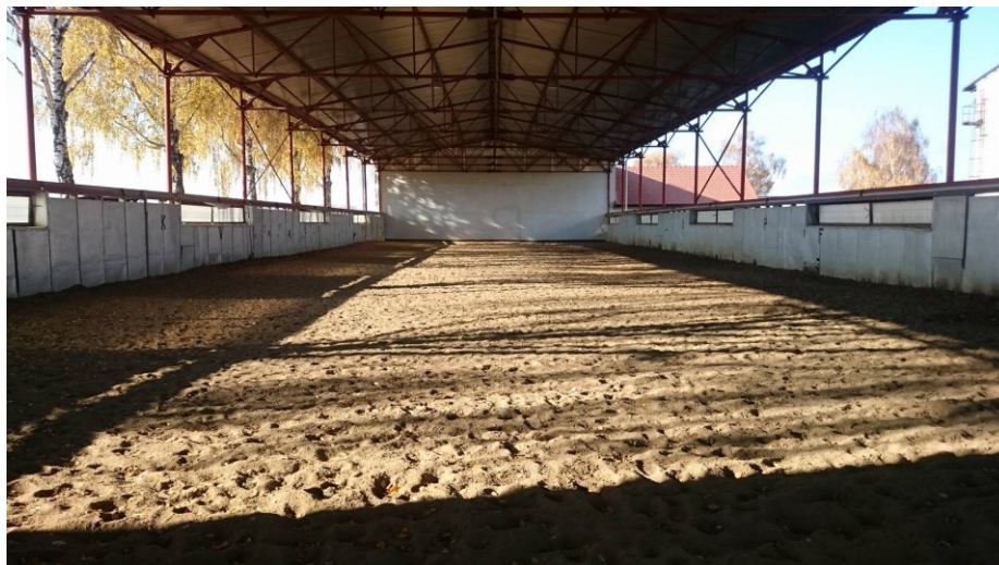
Obrázek 14. Hala – pohled zevnitř
