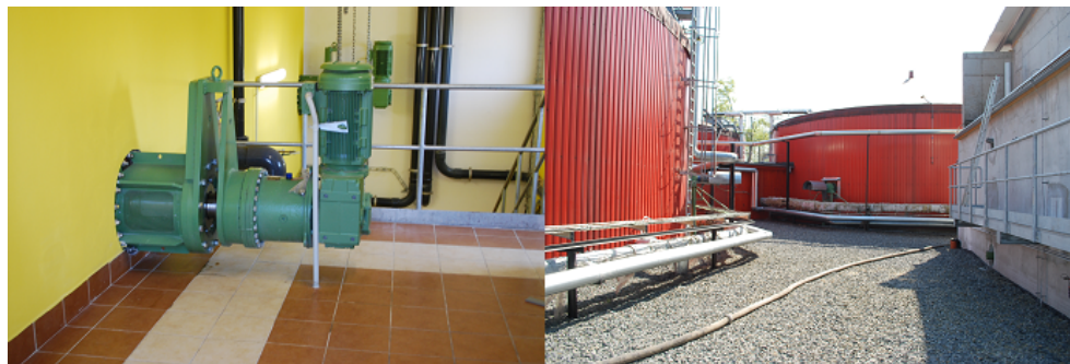
Obrázek 5.3: Vlevo: míchadlo primárního fermentoru, vpravo: fermentory
