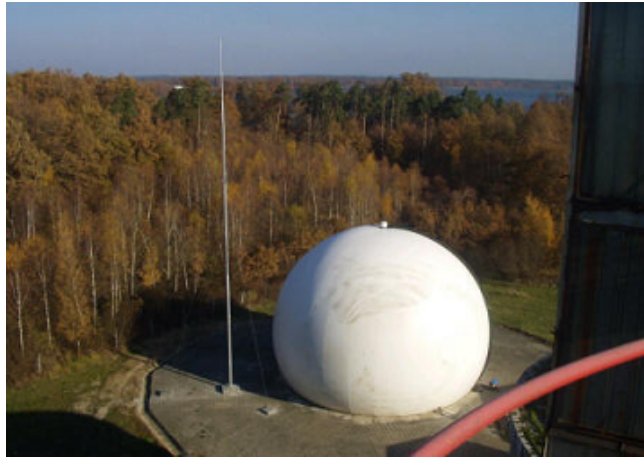
Obrázek 4.9: Dvoumembránový plynojem Sattler na BPS Třeboň [15]
