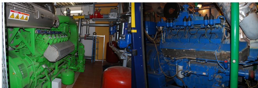
Obrázek 5.5: Zleva motor Jenbacher JMS 412, napravo Tedom Quanto D500.
