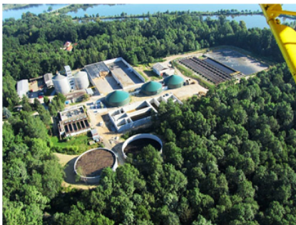
Obrázek 4.2: Zemědělská bioplynová stanice Třeboň [24]
