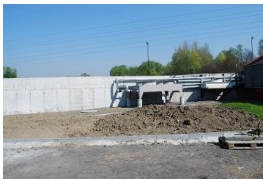
Obrázek 5.10: Systém odvodu tepla BPS Stonava
