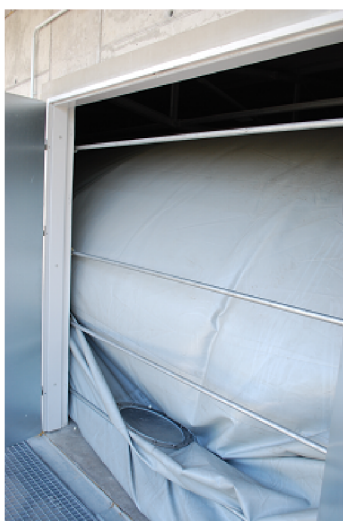
Obrázek 5.4: Membránový primární plynojem
