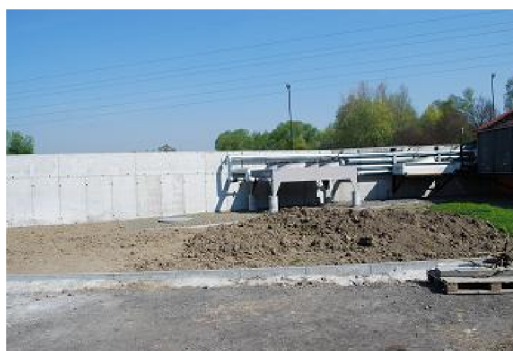
Obrázek 5.10: Systém odvodu tepla BPS Stonava
