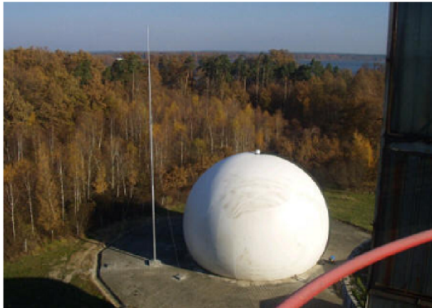
Obrázek 4.9: Dvoumembránový plynojem Sattler na BPS Třeboň [15]
