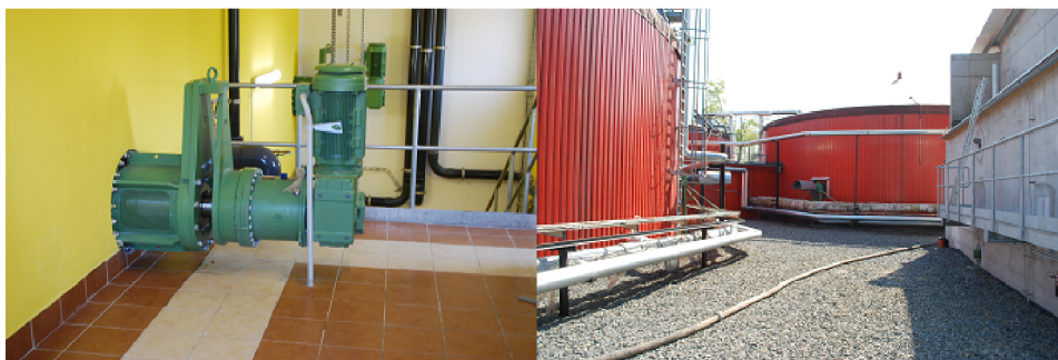
Obrázek 5.3: Vlevo: míchadlo primárního fermentoru, vpravo: fermentory
