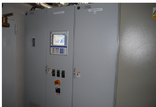
Obrázek 5.6: Řídící jednotka motoru Jenbacher JMS 412
