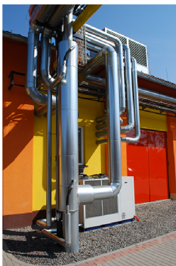
Obrázek 5.9: Chladicí jednotka BPS Stonava
