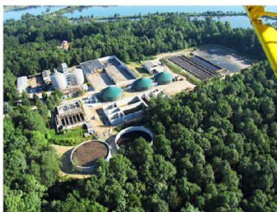
Obrázek 4.2: Zemědělská bioplynová stanice Třeboň [24]
