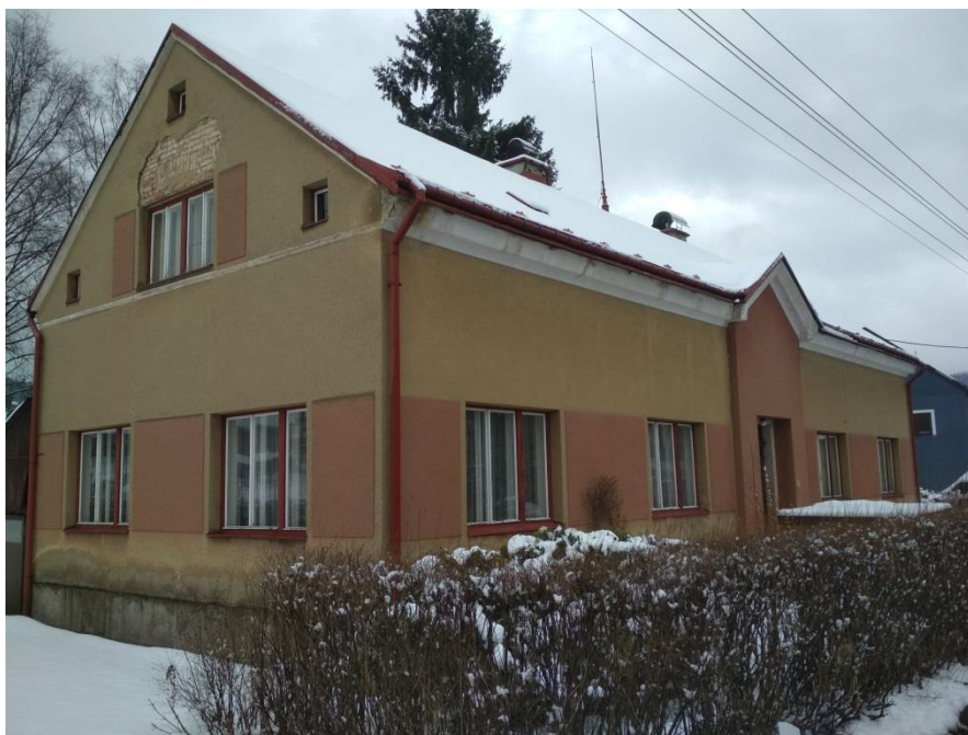
Obrázek 1: Celkový pohled na objekt od severozápadu
