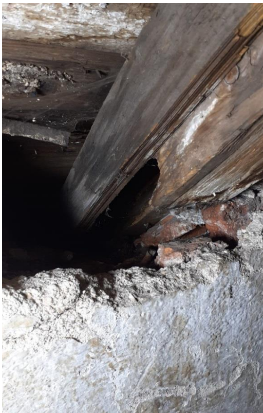
Obrázek 11, 12: Poškození KM 2 - detail uhníléch přesahů krokvi KR 12 (vlevo) a KR 13 (vpravo)
