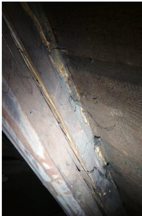
Obrázek 15, 16: Poškození KM 1 - poškození Tesaříkem fialový ( Callidium violaceum ) na krokách KR 1 a KR 5
