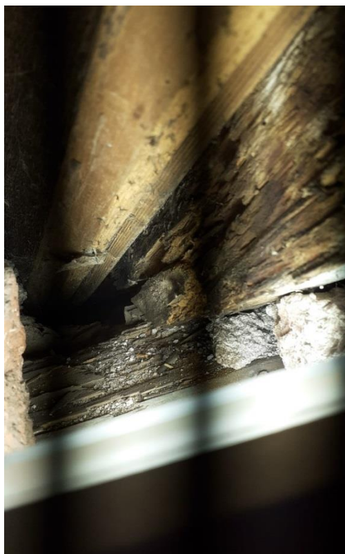
Obrázek 11, 12: Poškození KM 2 - detail uhníléch přesahů krokvi KR 12 (vlevo) a KR 13 (vpravo)
