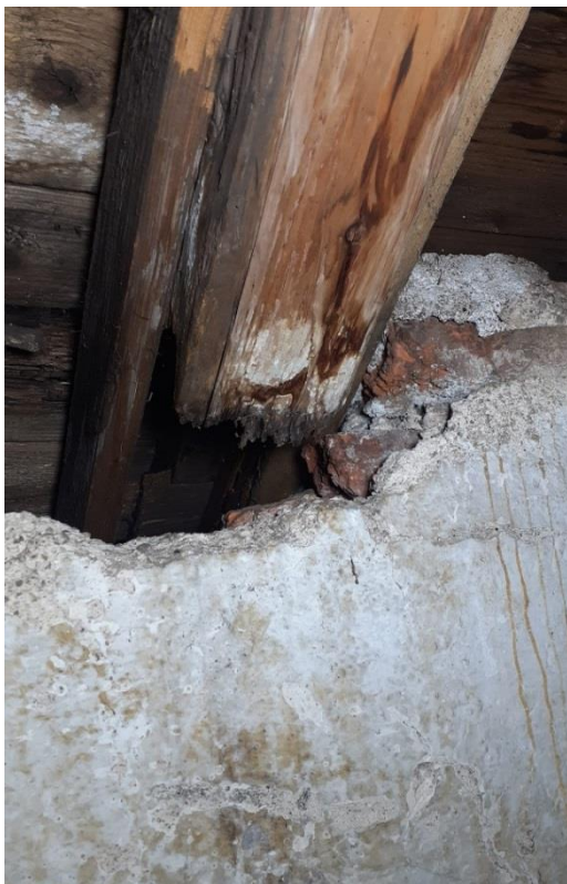
Obrázek 13, 14: Poškození KM 2 - detail uhnílého přesahu krokve KR 14 (vlevo) a poškozená krokev KR 17 (vpravo)
