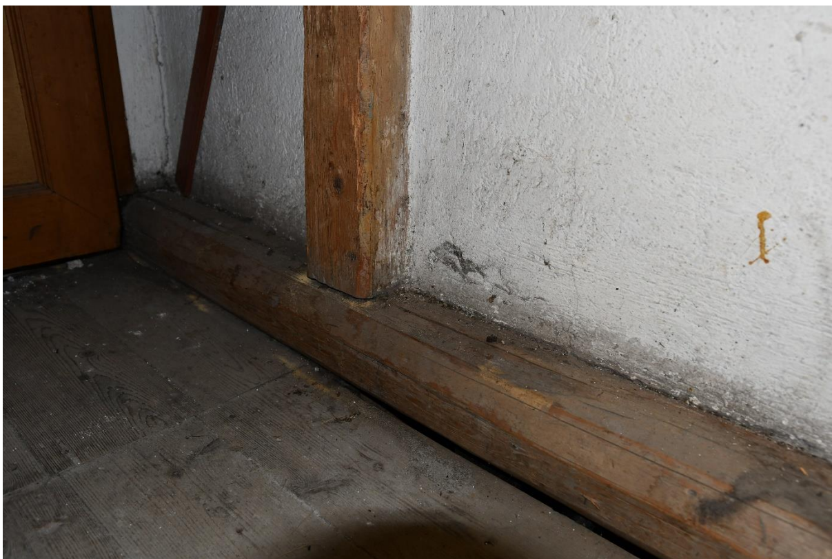
Obrázek 19: Poškození KM 4 - celkový pohled na poškozený sloupek T3
