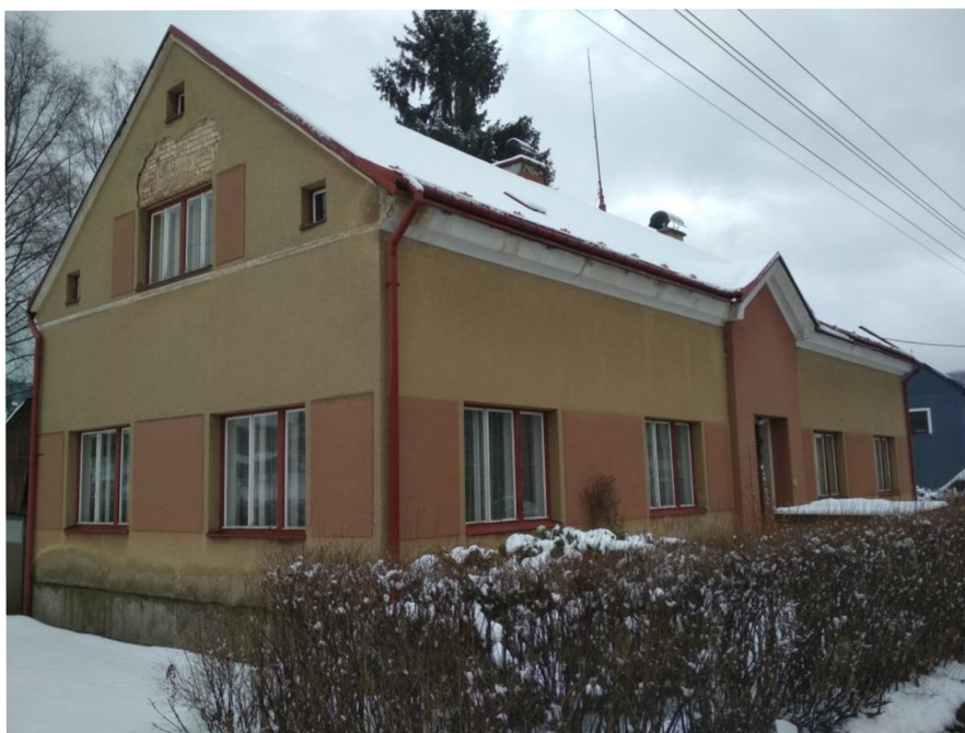
Obrázek 1: Celkový pohled na objekt od severozápadu
