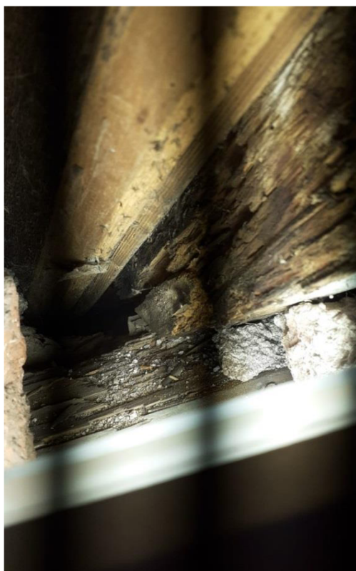
Obrázek 11, 12: Poškození KM 2 - detail uhnílejších přesahů krokví KR 12 (vlevo) a KR 13 (vpravo)
