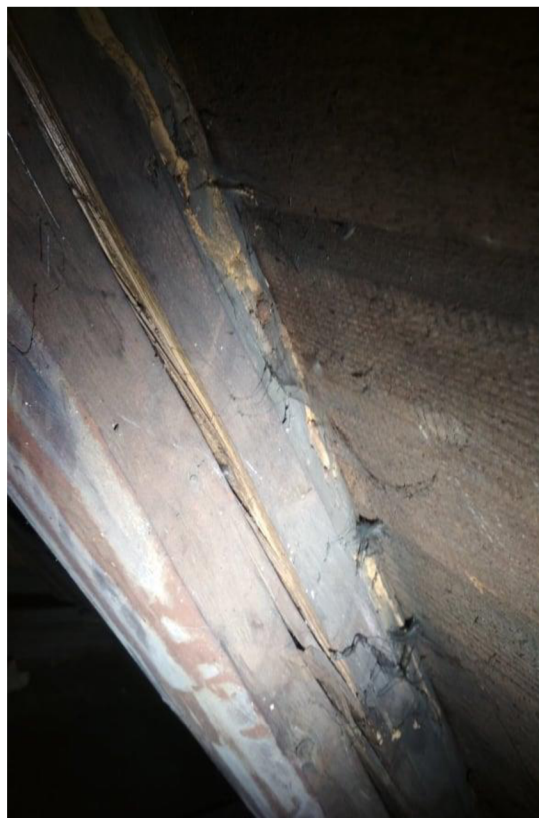
Obrázek 15, 16: Poškození KM 1 - poškození Tesaříkem fialový ( Callidium violaceum ) na krokvích KR 1 a KR 5
