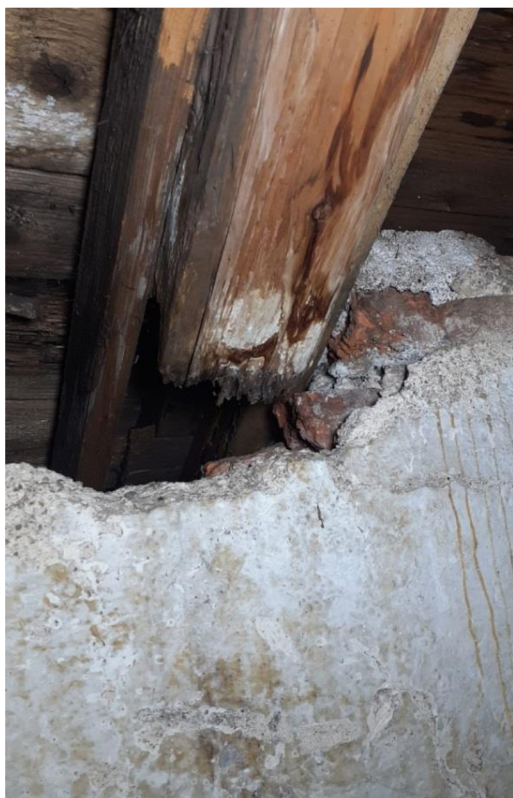
Obrázek 13, 14: Poškození KM 2 - detail uhnílejšího přesahu krokve KR 14 (vlevo) a poškozená krokev KR 17 (vpravo)
