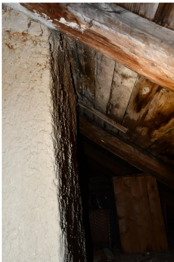
Obrázek 4, 5 : Poškození KM 3 - poškozené prvky KR 10, KR 11 a dřevěného bednění
