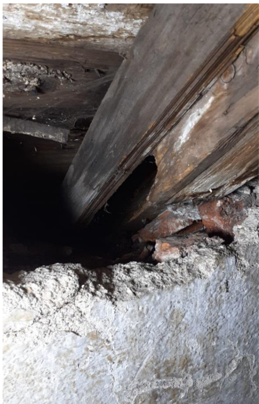
Obrázek 11, 12: Poškození KM 2 - detail uhnílejších přesahů krokví KR 12 (vlevo) a KR 13 (vpravo)
