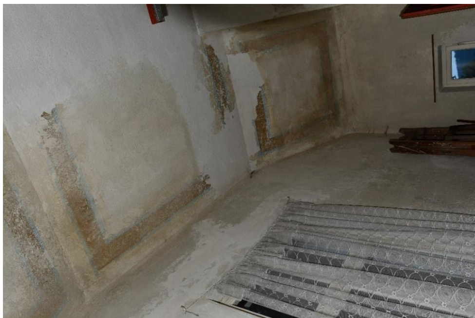
Obrázek 9: Rákosový strop ve schodišťovém křídle (Vlastní tvorba)
