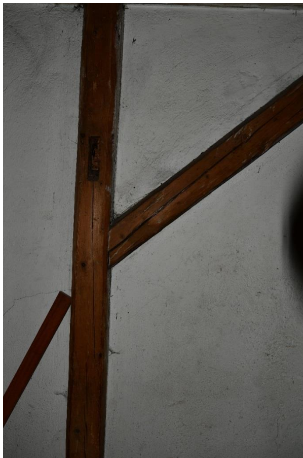
Obrázek 11: Nalezené dlaby po vzpěrách (Vlastní tvorba)
