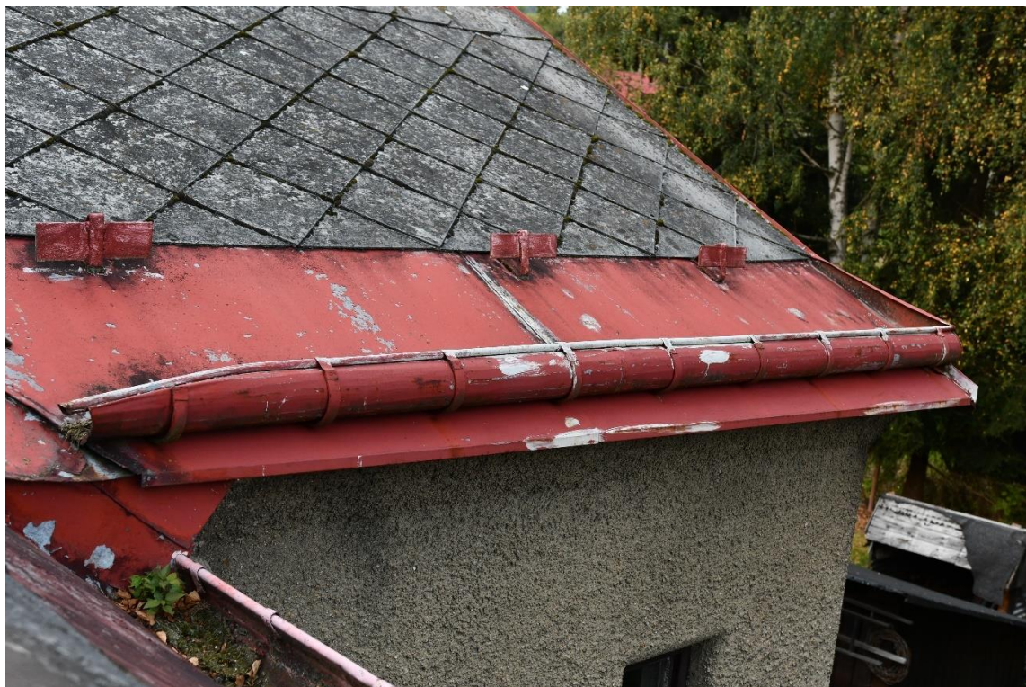
Obrázek 12: Zanesené okapové žlaby (Vlastní tvorba)
