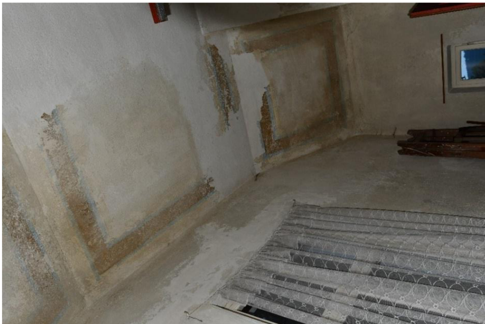
Obrázek 9: Rákosový strop ve schodišťovém křídle (Vlastní tvorba)
