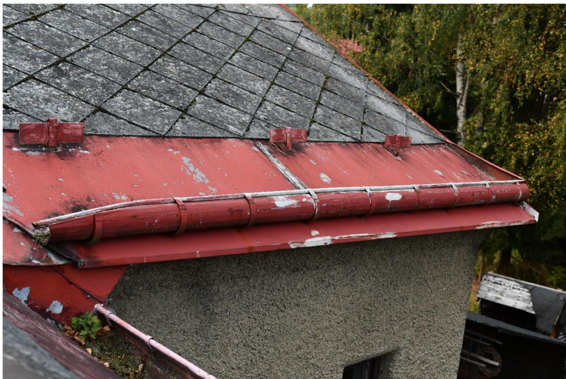
Obrázek 12: Zanesené okapové žlaby (Vlastní tvorba)
