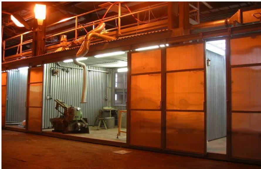
Obrázek 12 Fragmentační a dekontaminační středisko ÚJV Řež (zdroj Podlaha, 2002)
