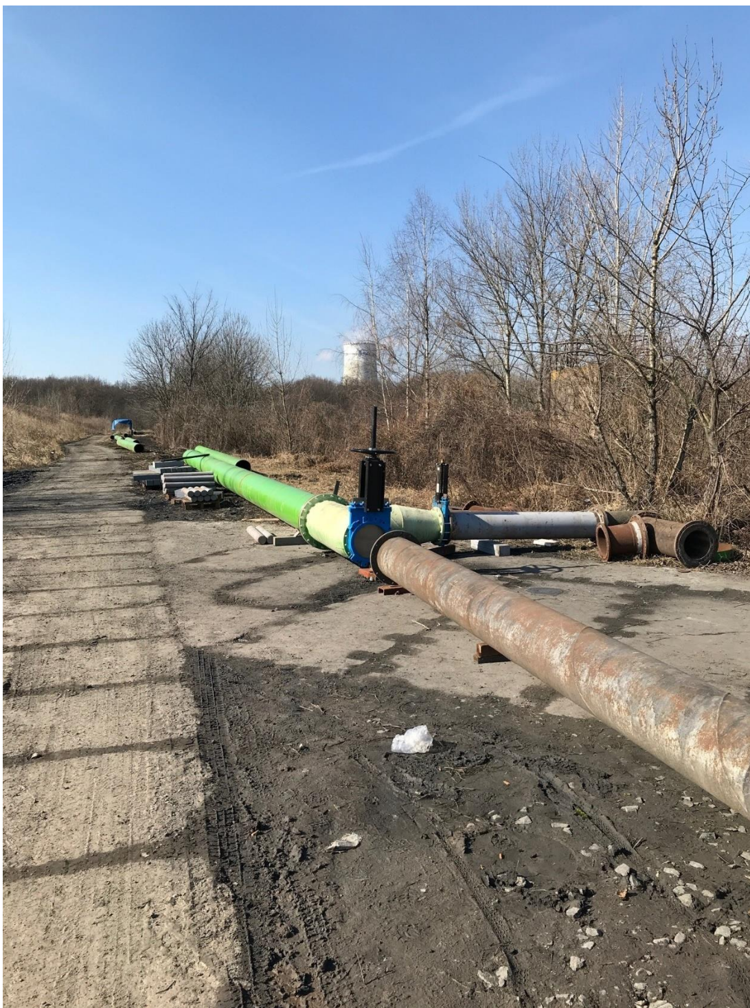
Příloha č. 5 – Příprava zapojení potrubí. Březen 2021.
