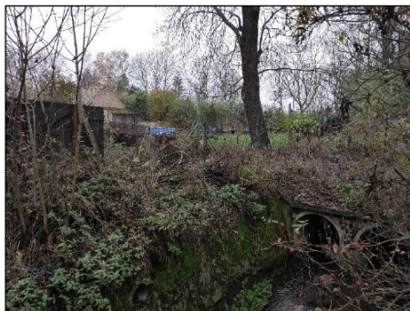
pohled z dolní vody na objekt
