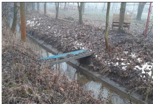
pohled z horní vody na objekt
