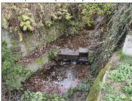
pohled na koryto z (od) objektu proti vodě
