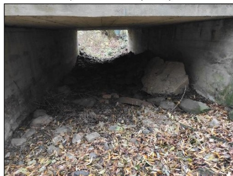
pohled z dolní vody na objekt
