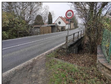
Celkový pohled na objekt
