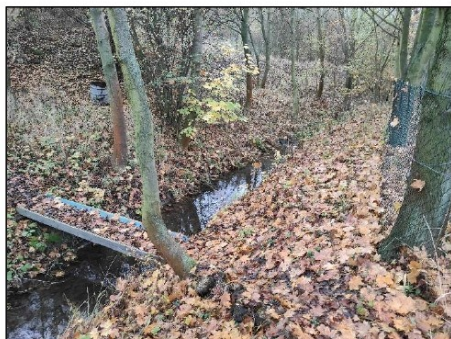
Celkový pohled na objekt
