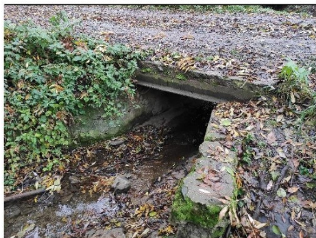
pohled z horní vody na objekt
