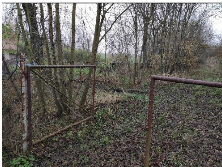
pohled z horní vody na objekt
