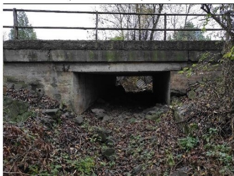
pohled z horní vody na objekt
