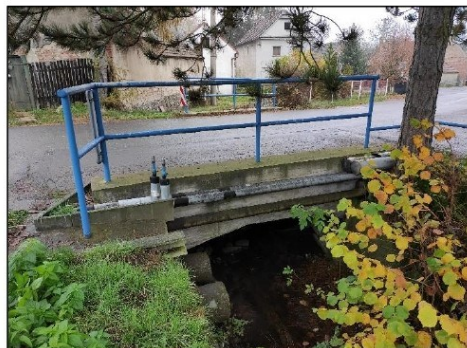
Celkový pohled na objekt
