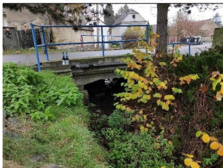
pohled z horní vody na objekt
