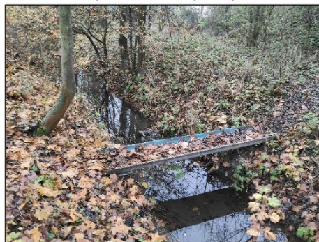
pohled z dolní vody na objekt
