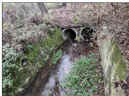
Celkový pohled na objekt
