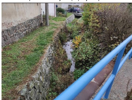
pohled na koryto z (od) objektu po vodě
