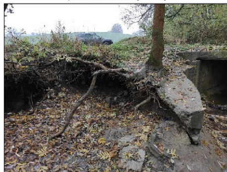
pohled z dolní vody na objekt
