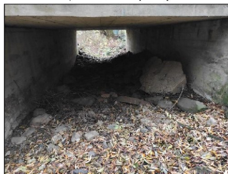
pohled z dolní vody na objekt
