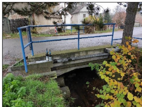
Celkový pohled na objekt
