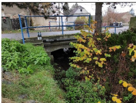
pohled z horní vody na objekt
