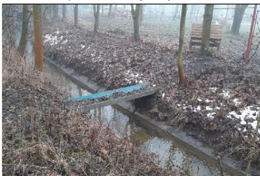
pohled z horní vody na objekt
