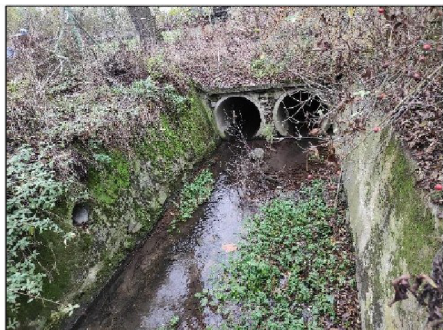
Celkový pohled na objekt
