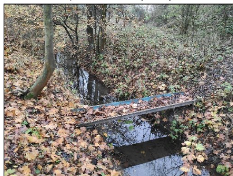
pohled z dolní vody na objekt
