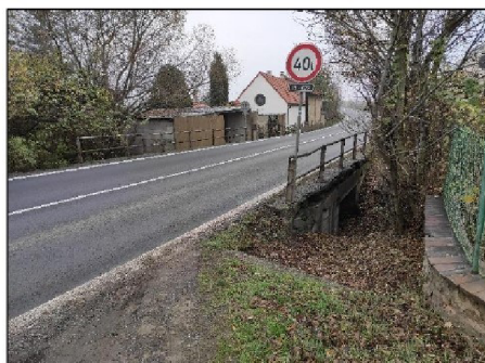
Celkový pohled na objekt
