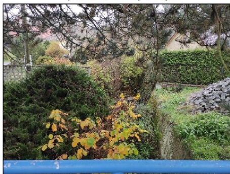
pohled z dolní vody na objekt
