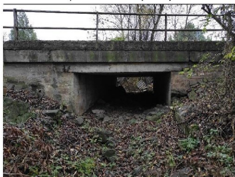
pohled z horní vody na objekt
