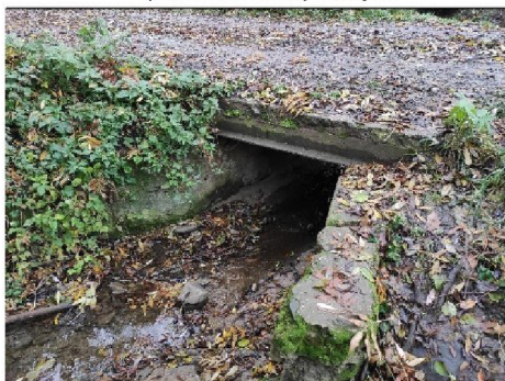
pohled z horní vody na objekt
