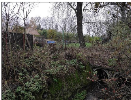
pohled z dolní vody na objekt
