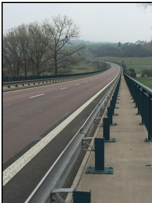
OBRÁZEK Č. 14: ZÁBRADLÍ NA MOSTĚ PŘES ŘEKU ZDOBNICI
