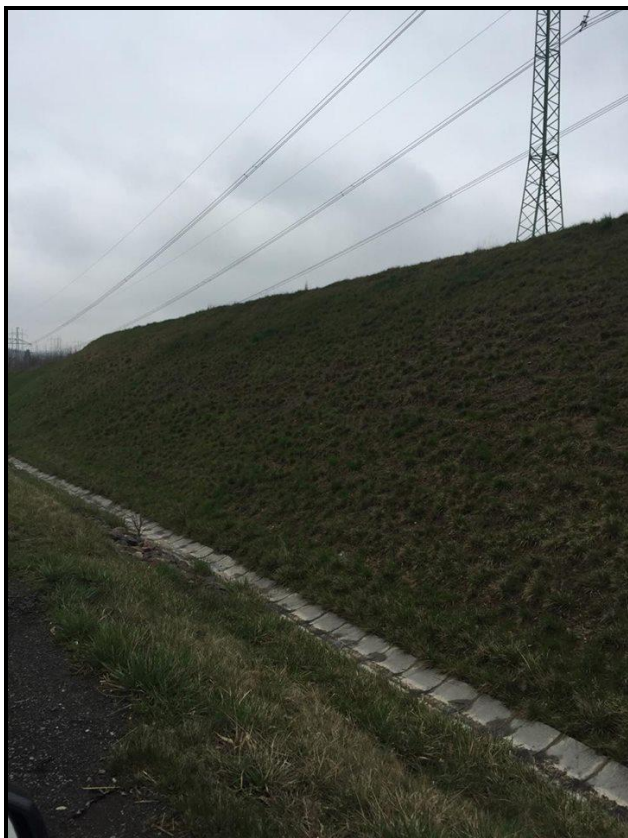
OBRÁZEK Č. 17: ODVODŇOVACÍ PŘÍKOP
