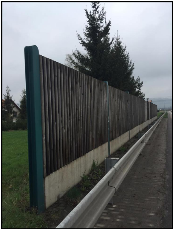
OBRÁZEK Č. 12: PROTIHLUKOVÁ OPATŘENÍ
