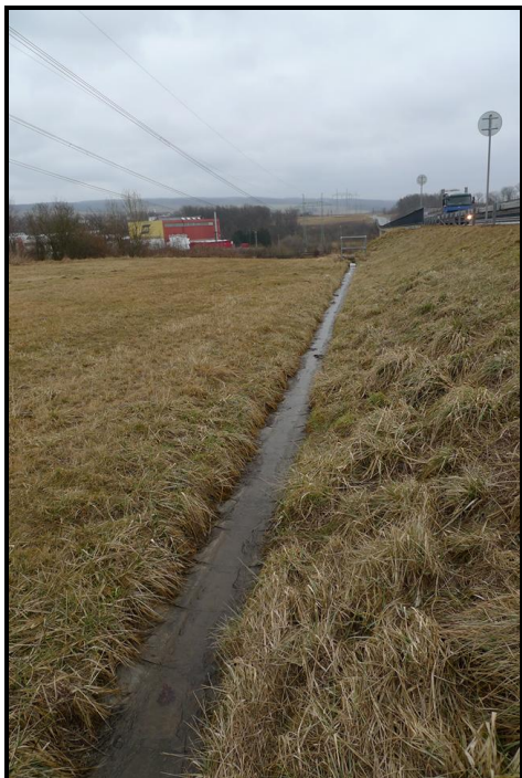
OBRÁZEK Č. 22: SVOD DEŠŤOVÉ VODY
