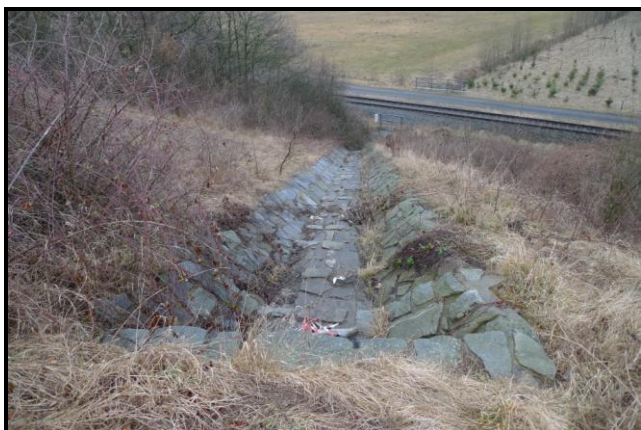
OBRÁZEK Č. 23: SVOD DEŠŤOVÉ VODY
