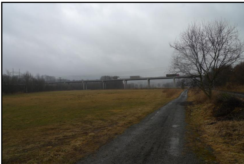
OBRÁZEK Č. 26: KOMUNIKACE POD MOSTNÍM OBJEKTEM
