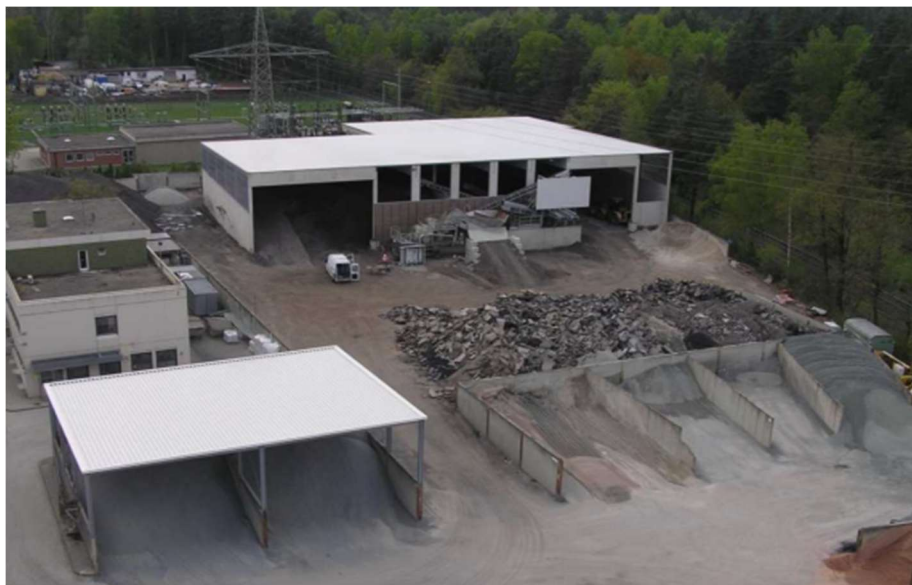
Obrázek 11: Skládka R-materiálu s tříděním a zastřešením [16]
