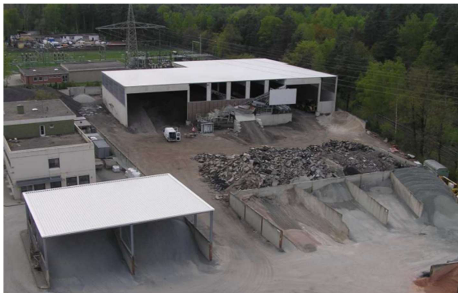
Obrázek 11: Skládka R-materiálu s tříděním a zastřešením [16]
