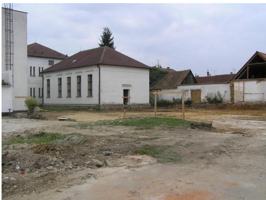
Obr. č. 2: Začátek výstavby nové MŠ ( zdroj:www.dolnibukovsko.cz )
