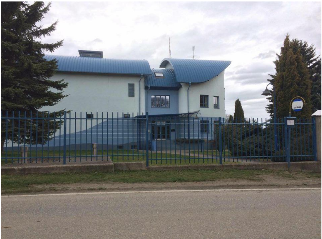
Obr. č. 19: Hlavní budova vodárny
