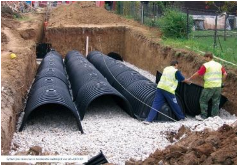
Obrázek 3 – Tunelový zasakovací objekt (Vacek, 2018)
