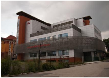
Obr. 22 Integrované bezpečnostní centrum Moravskoslezského kraje (zdroj: http://www.vyfotprojekt.cz/galerie/integrované-bezpečnostní-centrum-moravskoslezského-kraje-0 )
