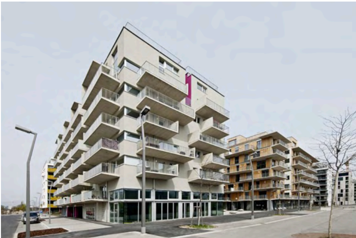
Obr. 19 Nordbahnhof - Wohnen mit scharf!, fotografie 350
