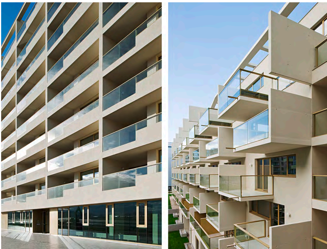
Obr. 31 PLATFORM L, uliční a dvorní fasáda, fotografie 364
