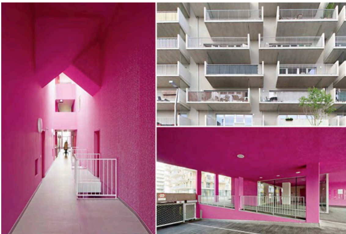
Obr. 20 Nordbahnhof - Wohnen mit scharf!, fotografie 351
