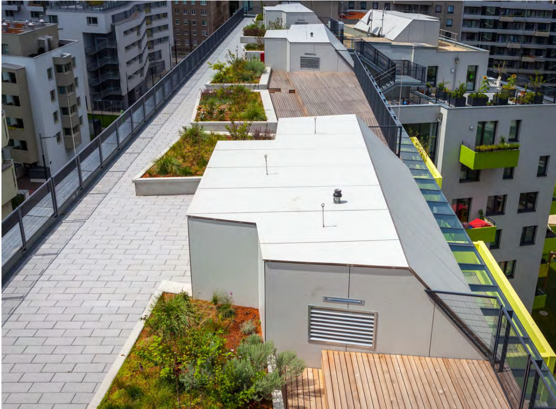
Obr. 37 SO.VIE.SO, střešní terasa, fotografie 371
