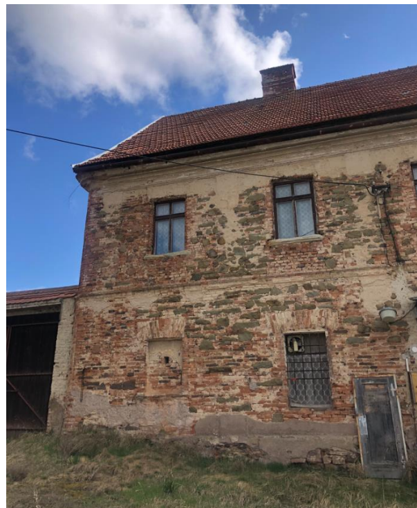
Obr. 7: Pohled na stavbu ze dvora [zdroj: vlastní foto]
