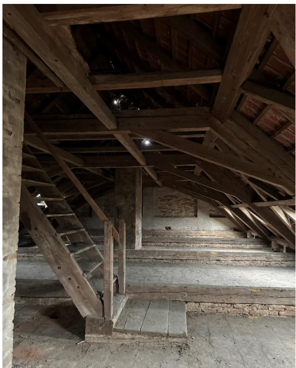
Obr. 41: Krov, focený z půdy [zdroj: vlastní]
