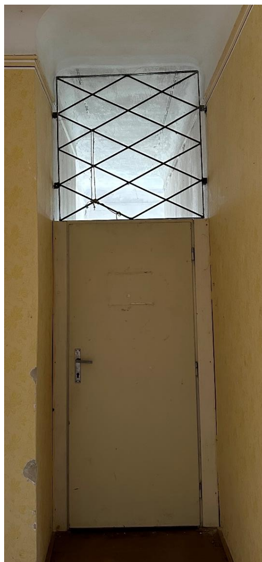
Obr. 33: Dveře do technické místnosti [zdroj: vlastní foto]
