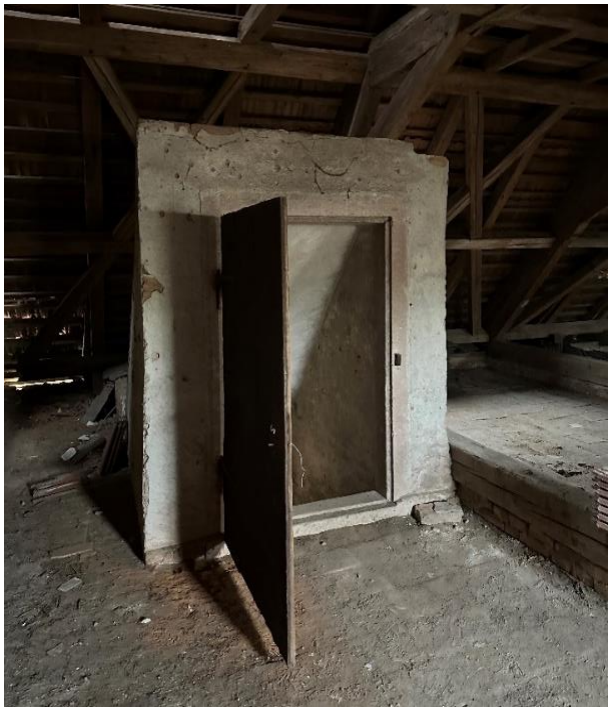
Obr. 47: Vstupní dveře na půdu [zdroj: vlastní foto]
