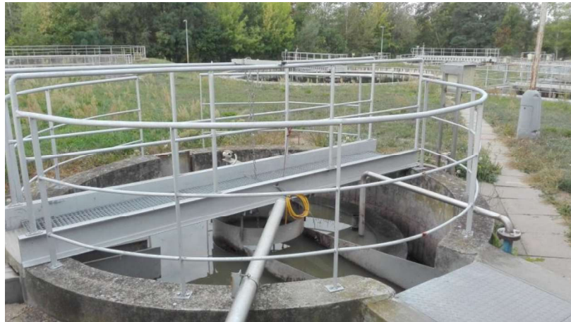
Obrázek č. 12: Vertikální lapák písku – pračka písku
