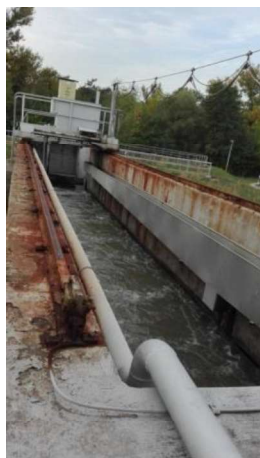
Obrázek č. 11: Strojně stírané česle, česlicový kanál s obtokem a ruční stavítka na obtokových žlabech
