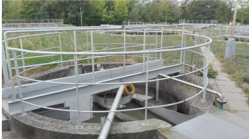
Obrázek č. 12: Vertikální lapák písku – pračka písku
