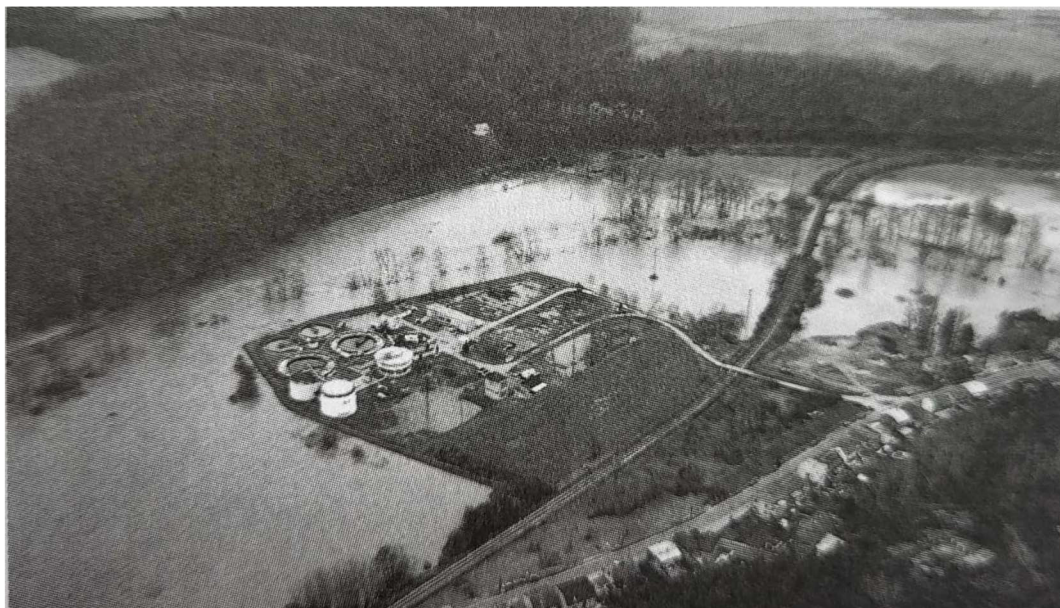
Obrázek č. 2: Čistírna odpadních vod v Mladé Boleslavi – letecký snímek z období povodní 10. 3. 2000
