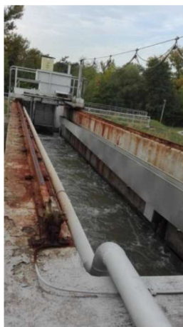
Obrázek č. 11: Strojně stírané česle, česlicový kanál s obtokem a ruční stavítka na obtokových žlabech
