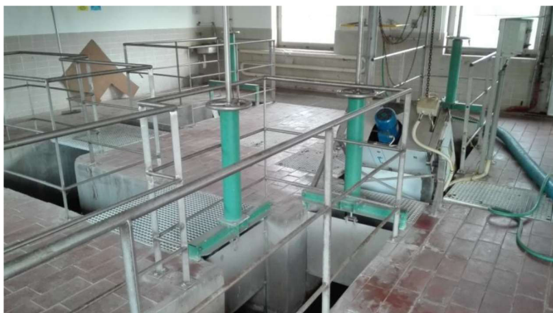
Obrázek č. 10: Strojně stírané česle, česlicový kanál s obtokem a ruční stavítka na obtokových žlabech
