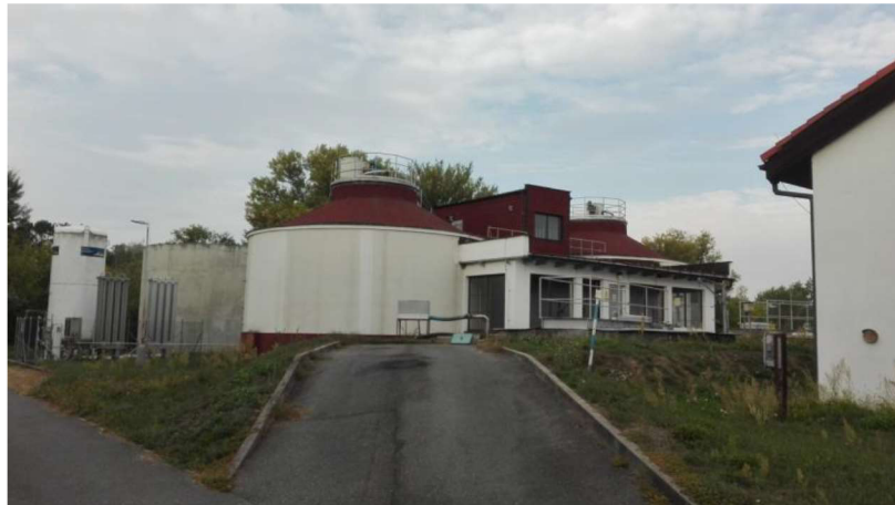
Obrázek č. 23: Vyrovnávací (UN1) a vychlazovací (UN3) nádrž s reaktory R1 a R2 (OSS) a odpařovací stanice kyslíku (vlevo)
