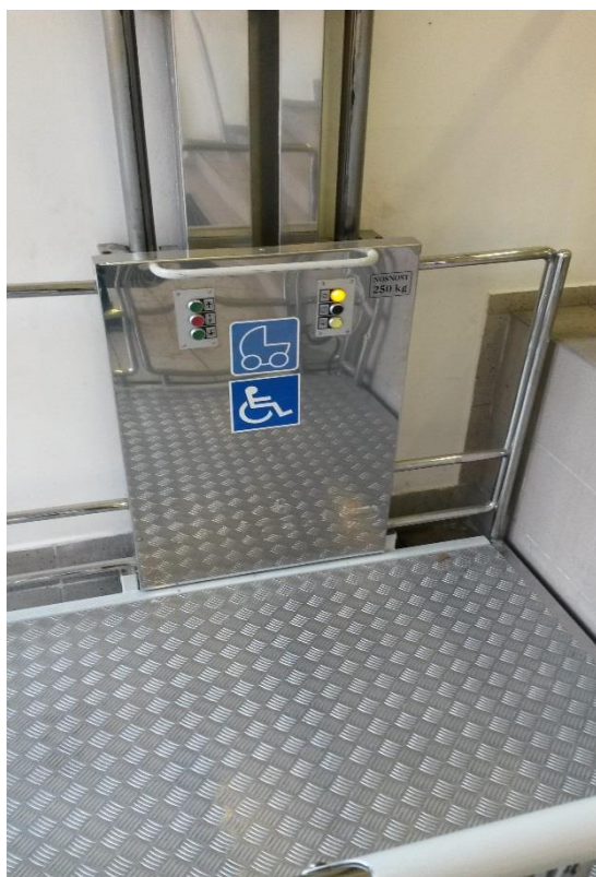
Obrázek 11: Zdvihací plošina u vstupu do Úřadu práce
