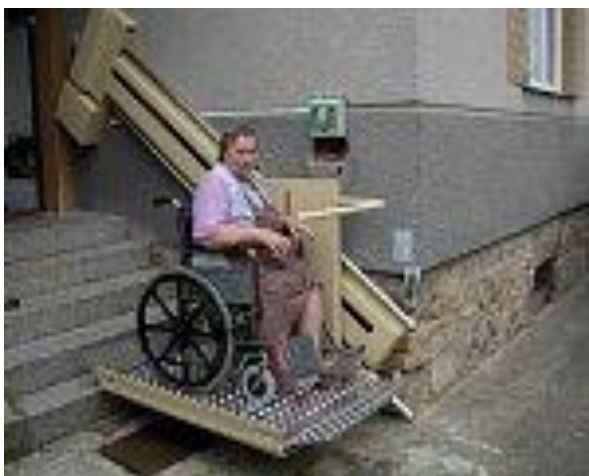
Obrázek 5: Šikmá zdvihací schodišťová plošina
