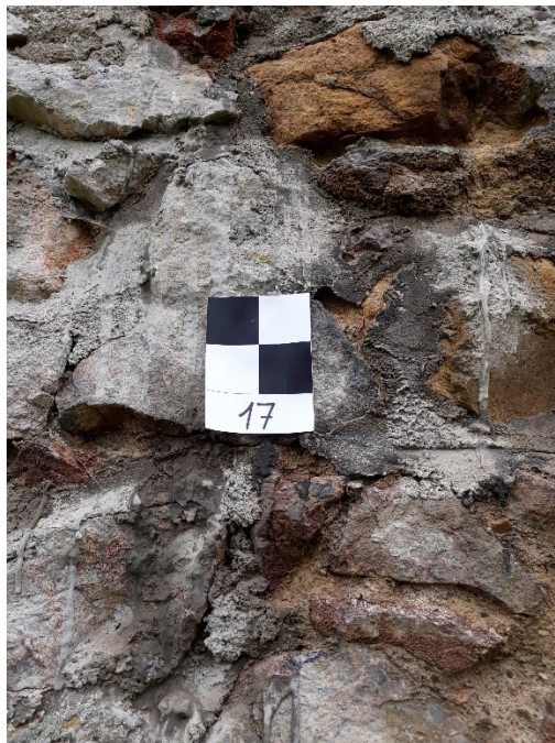
Obr. 5.3 – Vlíčovací bod v podobě šachovnicové terče (Foto K. Velecká)
