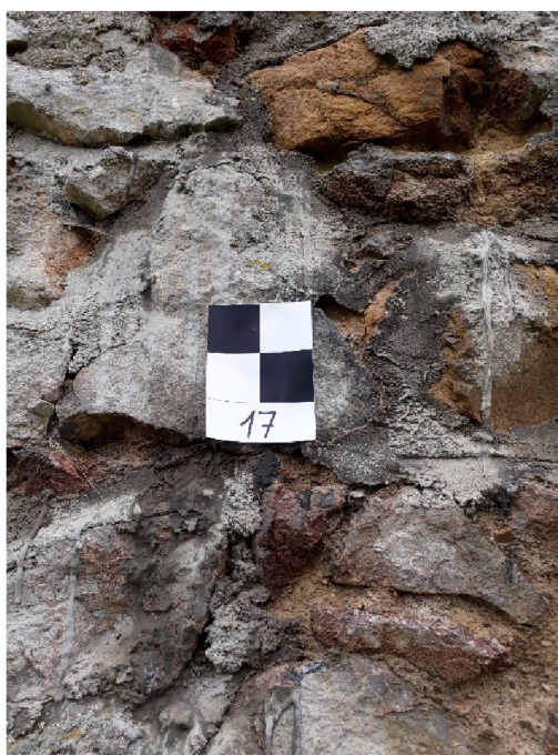
Obr. 5.3 – Vlícovací bod v podobě šachovnicové terče (Foto K. Velecká)
