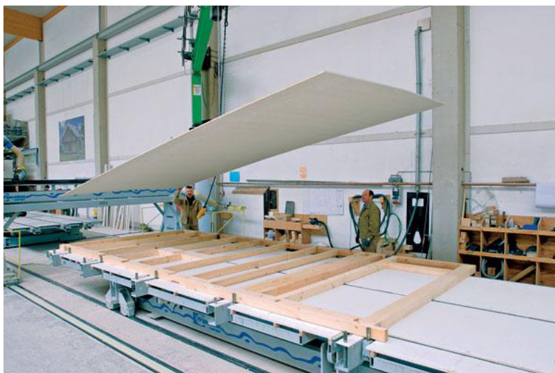
Obrázek 10 Výroba stěnových panelů prefabrikovaných rámových dřevostaveb.
