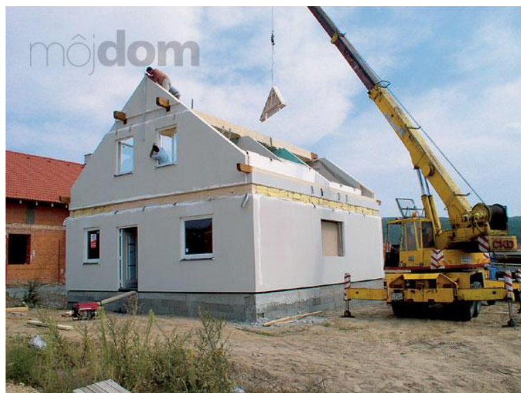
Obrázek 11 Montáž rámové konstrukce dřevostavby pomocí jeřábu.
