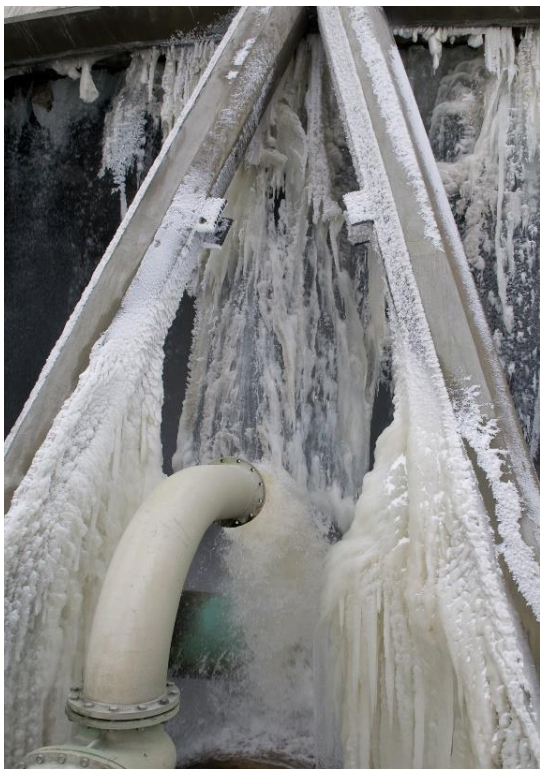
Obr. 9.6: Zamrzání chladicí věže [12]
