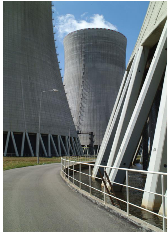
Obr. 6.2: Chladicí věž z blízkosti [11]
