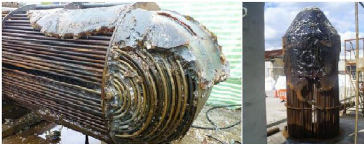
Obr. 20: Ukázka výměníku postiženého chemickým zanášením[25]
