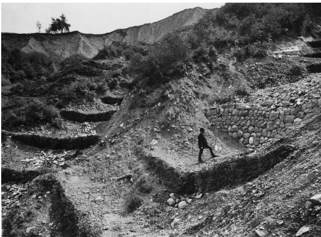
Obr. č. 14: Asanační opatření (terasy, přehrážky) na stržích v Senomatech, poskytl KŘOVÁK (2013), (zdroj neznámý)
