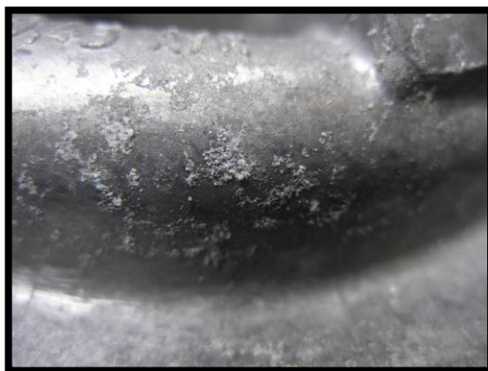
Obr. 19 Koroze na povrchu odlitku [10]
